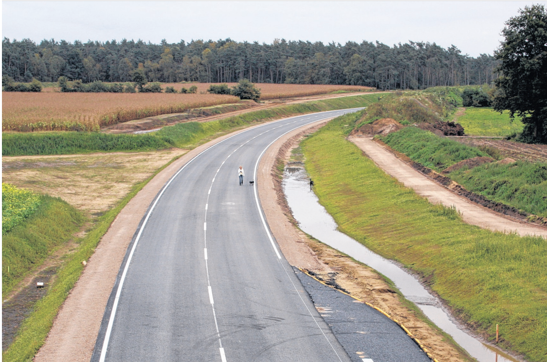
Die Ortsumgehung Thuine-Freren war 2006/2007 mit einer Länge von rund sechs Kilometern und Kosten von 10,2 Millionen Euro ein Großprojekt vom Geschäftsbereich Lingen der Landesbehörde für Straßenbau und Verkehr.
