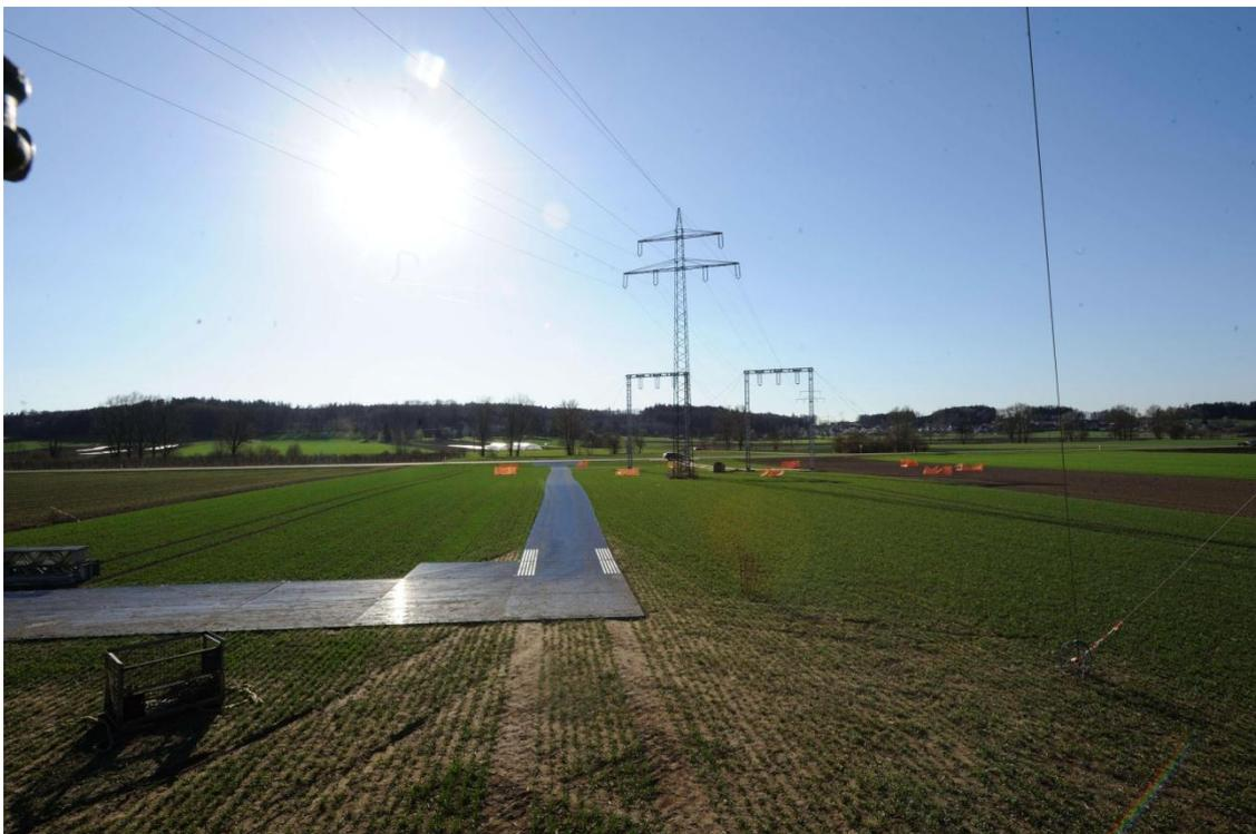
Abbildung 5: provisorische Zuwegung als Plattenzufahrt bei einer Freileitungsbaustelle
