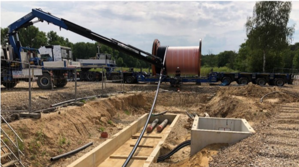
Abbildung 18: Beispiel für den Kabelzug am Abspulplatz, Quelle: Amprion GmbH
