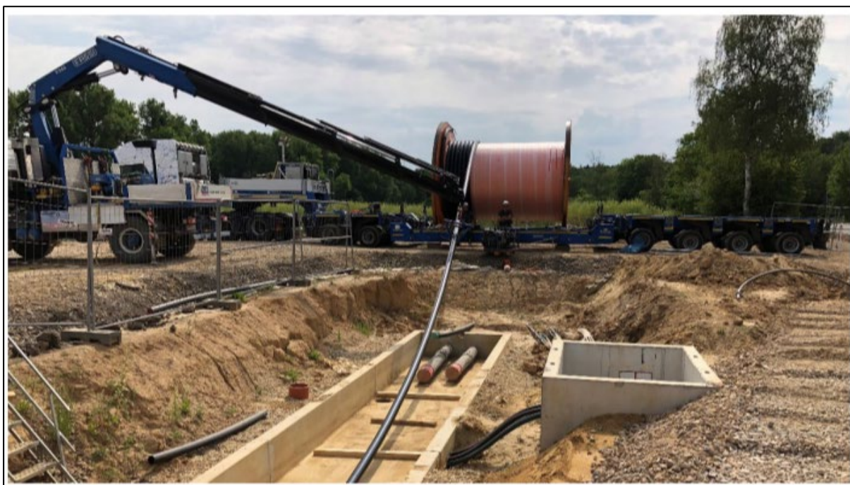
Abbildung 14: Beispiel für den Kabelzug am Abspulplatz, Quelle: Amprion GmbH
