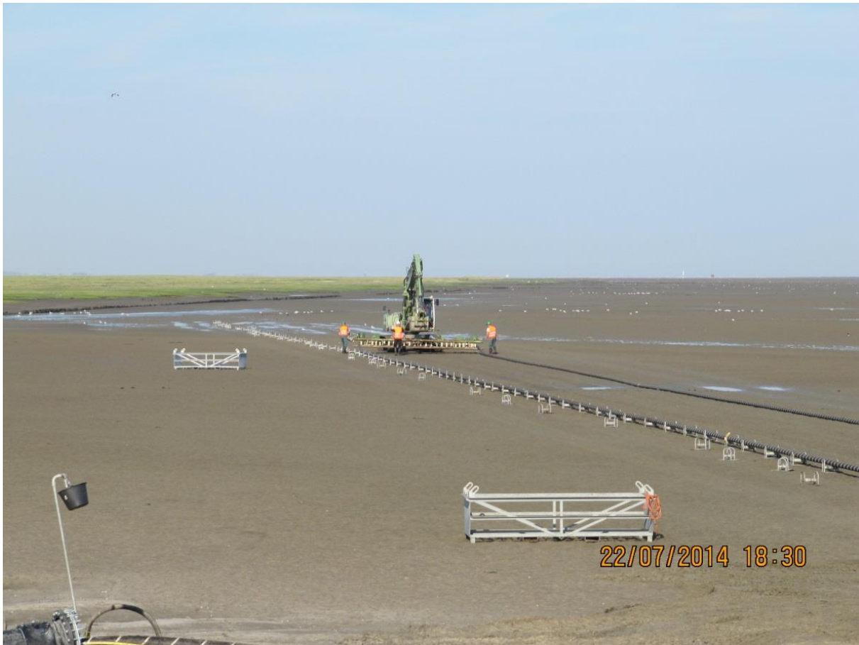
Abbildung 13: Auslegung der Kabelschleife (Quelle: eos projekt)
