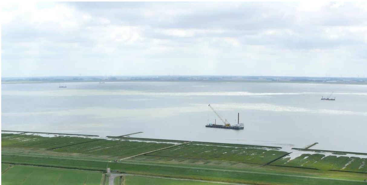
Abbildung 11: Beispielhafte Wasserbaustelle im Norderneyer Inselwatt (Quelle: MOLL-prd)
