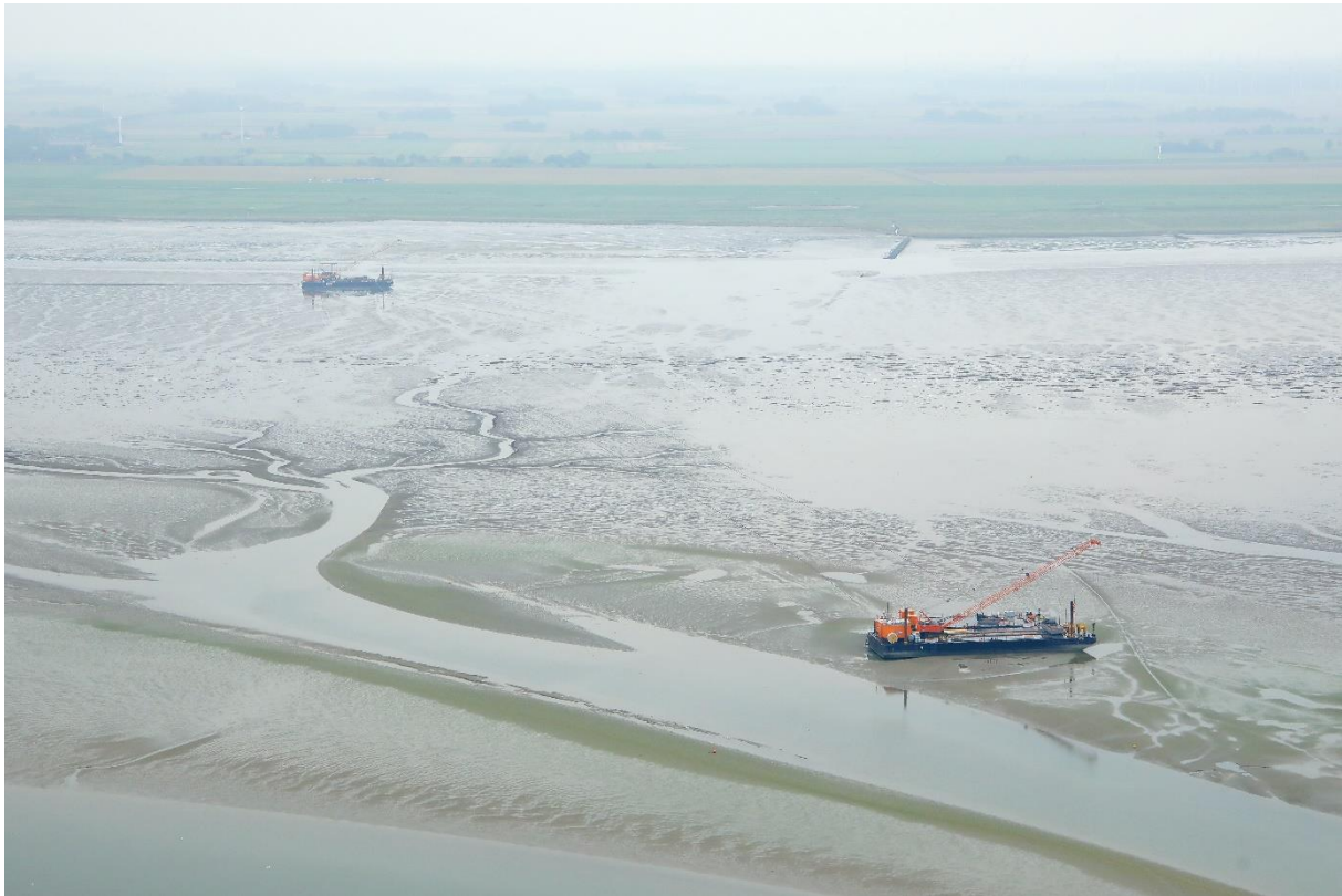
Abbildung 9: Luftbild einer exemplarischen Wasserbaustelle bei Hilgenriedersiel mit dem Arbeitsponton am Bohraustrittspunkt im Hintergrund und dem Anlege- und Fährponton am Riffgat-Fahrwasser im Vordergrund (Quelle: TenneT)
