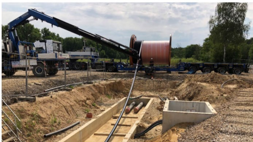
Abbildung 23: Beispiel für den Kabelzug am Abspulplatz, Quelle: Amprion GmbH
