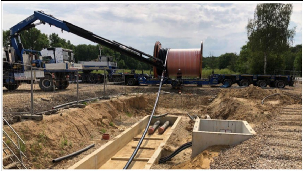
Abbildung 15: Beispiel für den Kabelzug am Abspulplatz, Quelle: Amprion GmbH
