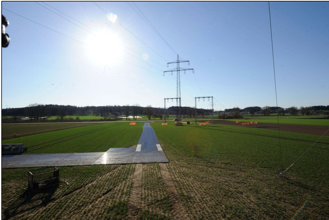
Abbildung 12: Baustraße als Plattenzufahrt bei einer Freileitungsbaustelle
