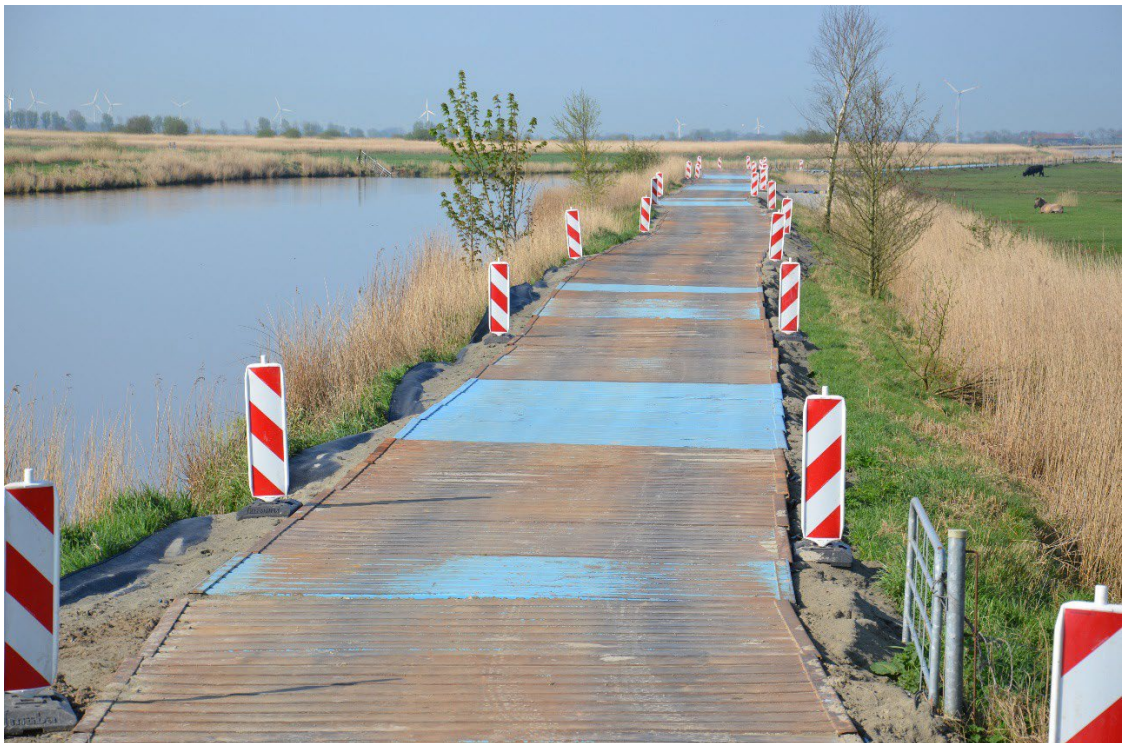
Abbildung 17: Provisorische Zuwegung als Plattenzufahrt bei einer Freileitungsbaustelle
