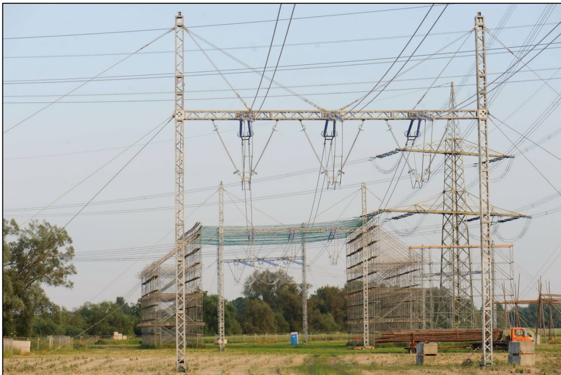
Abbildung 15: 380-kV-Freileitungsprovisorium für ein System, mit errichtetem Schutzgerüst
