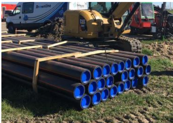
Abbildung 27: Fotos zur Vormontage der Leerrohre (links: Gebinde der Teilrohrstücke, rechts: Auslegen der Leerrohrstränge entlang des Trassenraums)
