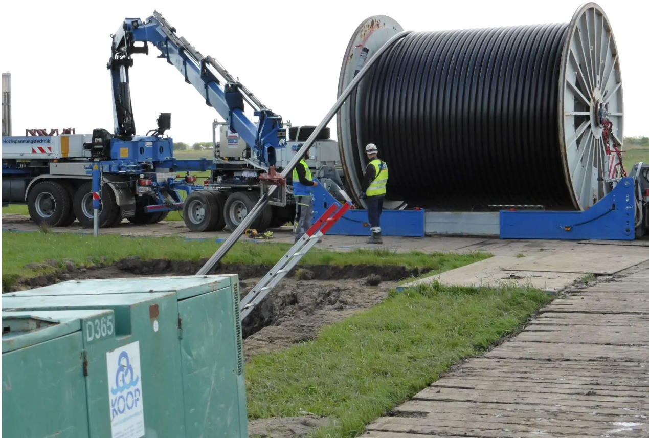
Abbildung 31: Beispiel Kabelzugarbeiten
