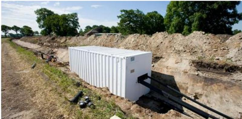
Abbildung 32: Beispiel für Muffengruben und -container
