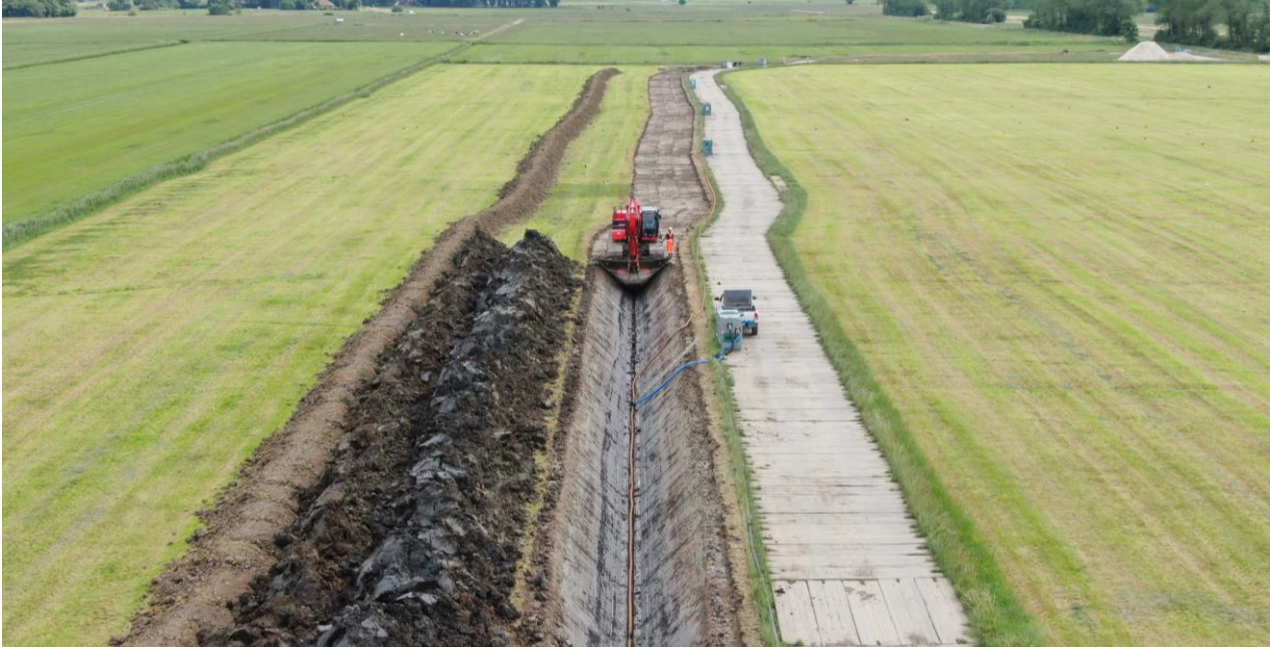
Abbildung 21: Beispiel Herstellung offener Kabelgraben (mit Baustraße und Bodenlager mit Bodentrennung)
