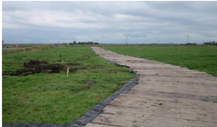
Abbildung 19: Beispiele für Baustraße mit Lastverteilungsmatten (Stahl und Holz auf Vlies)
