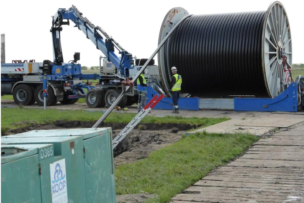
Abbildung 31: Beispiel Kabelzugarbeiten
