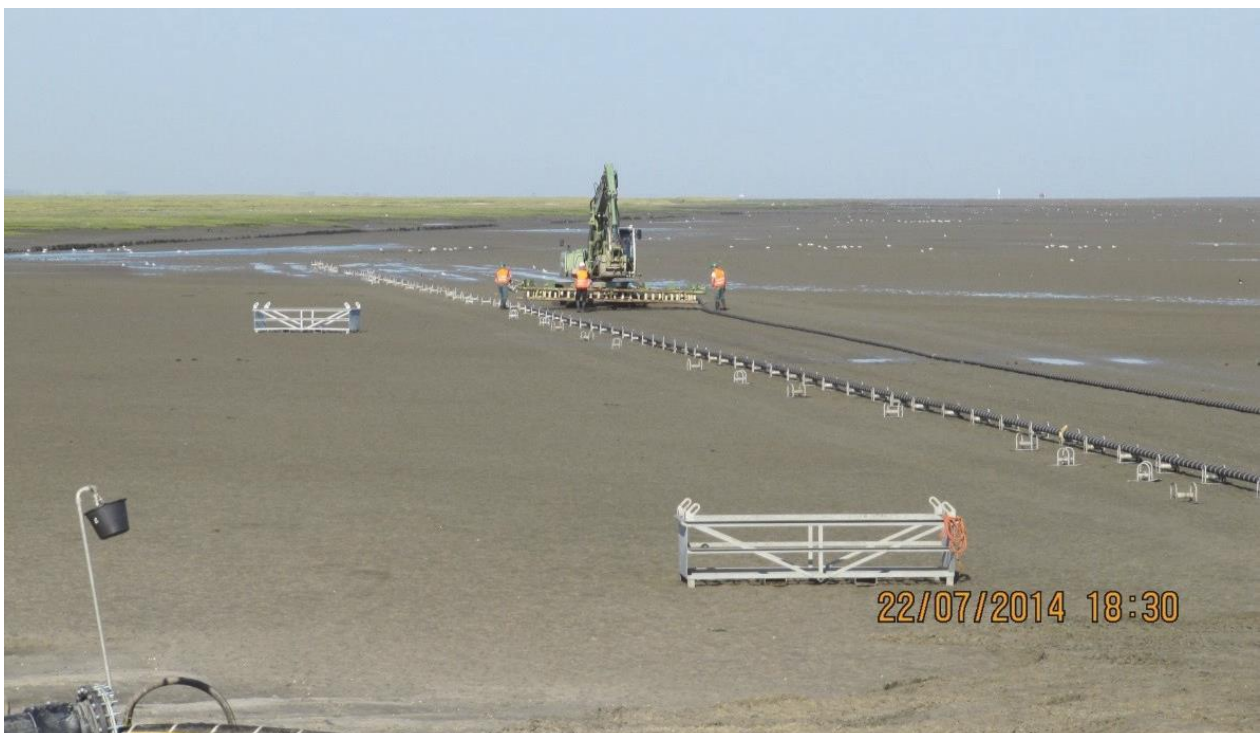
Abbildung 19: Auslegung der Kabelschleife (Quelle: eos projekt)
