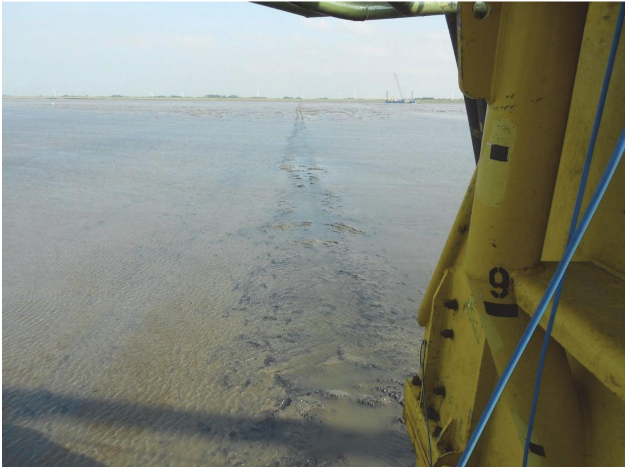
Abbildung 18: Kabelverlegung im Watt mit Hilfe eines Vibrationsschwertes (Quelle: eos projekt)
