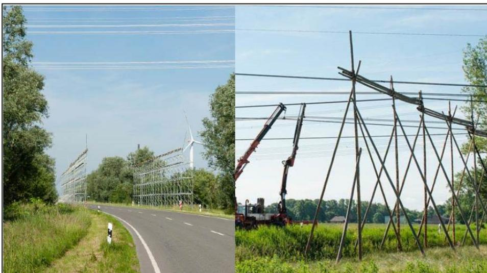
Abbildung 43: Beispiele für Schutzgerüste aus Stahl bzw. Holz
