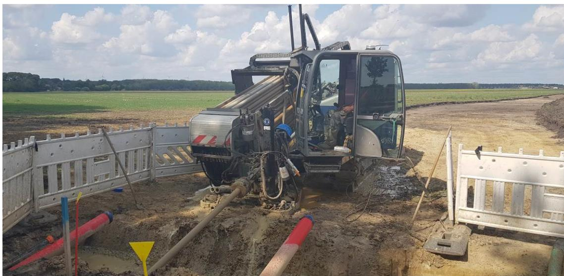
Abbildung 27: Bohrgerät für eine HD-Bohrung
