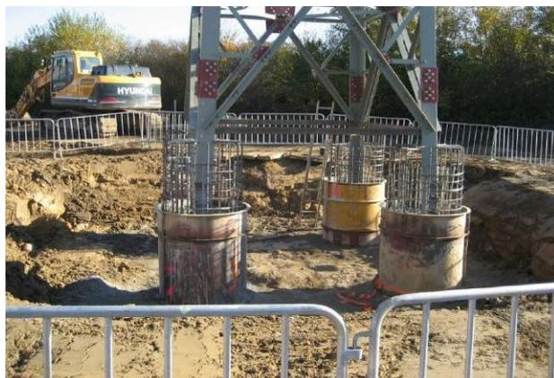
Abbildung 45: Fundamentverschalung mit Bewehrung und Mastunterkonstruktion
