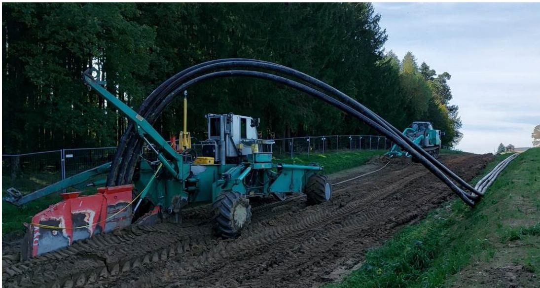
Abbildung 24: Einpflügen von 110-kV Erdkabeln im Pflugverfahren (Beispielbild)
