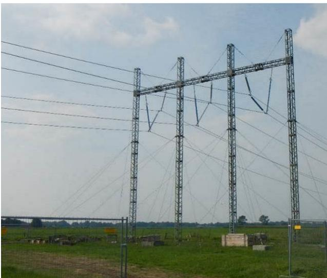
Abbildung 42: 1-systemiges Provisorium mit Verankerungen
