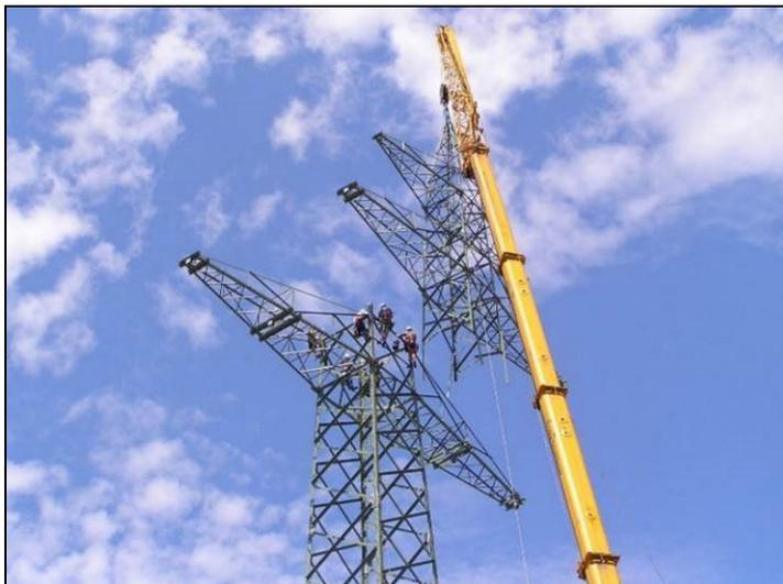
Abbildung 46: Aufstocken des Masten mit Mobilkran
