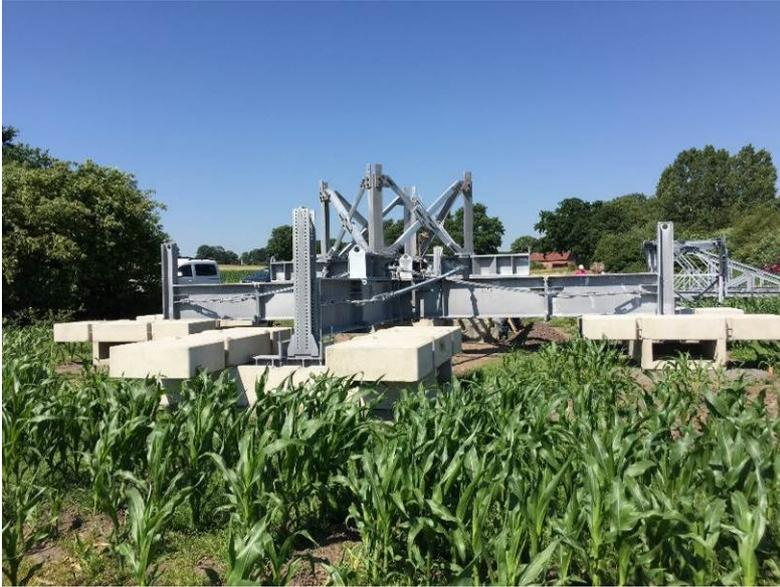
Abbildung 41: Auflastprovisorium Fußkreuz mit Mastunterteil, exemplarisch
