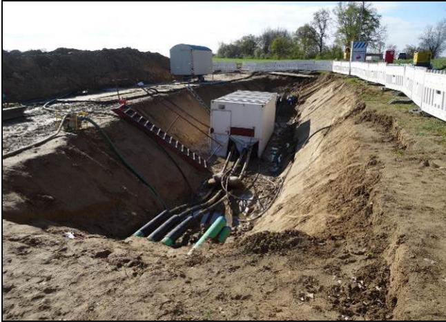
Abbildung 32: Muffengrube mit temporären Muffen-Container
