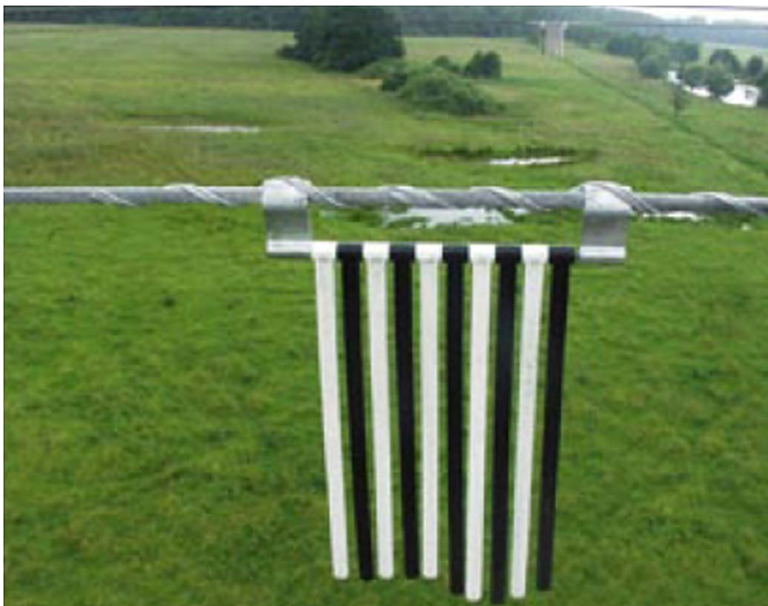
Abbildung 3: Beispiel einer schwarz-weißen Erdseilmarkierung (Quelle: RIBE)
