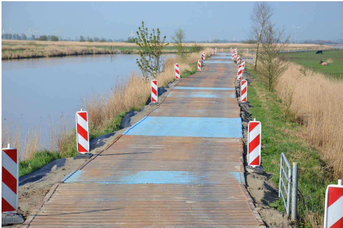
Abbildung 6: Provisorische Zuwegung als Plattenzufahrt bei einer Freileitungsbaustelle
