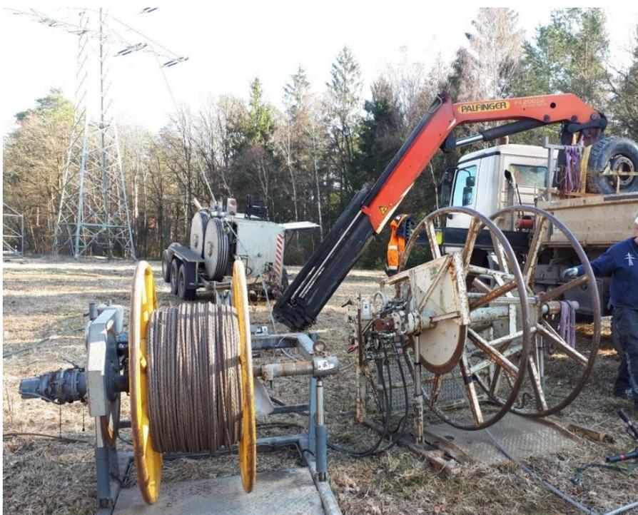
Abbildung 10: Beispiel für ein Seilzugverfahren (vorne: Seiltrommel, hinten: Seilzugmaschine)
