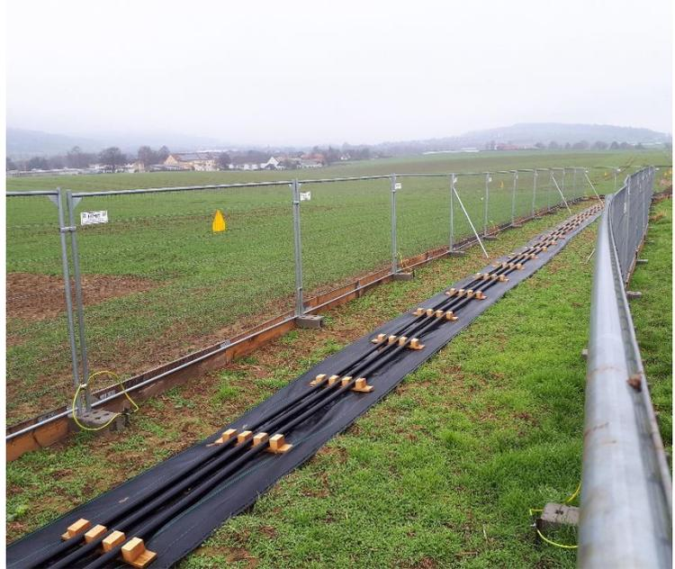
Abbildung 5: Beispiel eines Baueinsatzkabels
