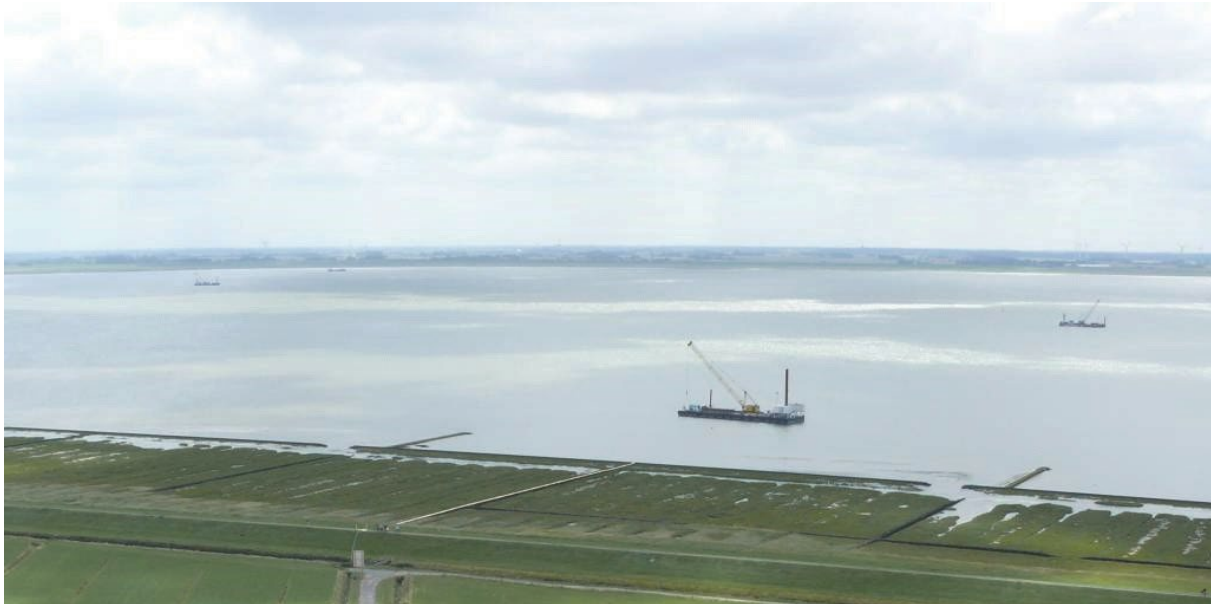
Abbildung 16: Beispielhafte Wasserbaustelle im Norderneyer Inselwatt (Quelle: MOLL-prd).
