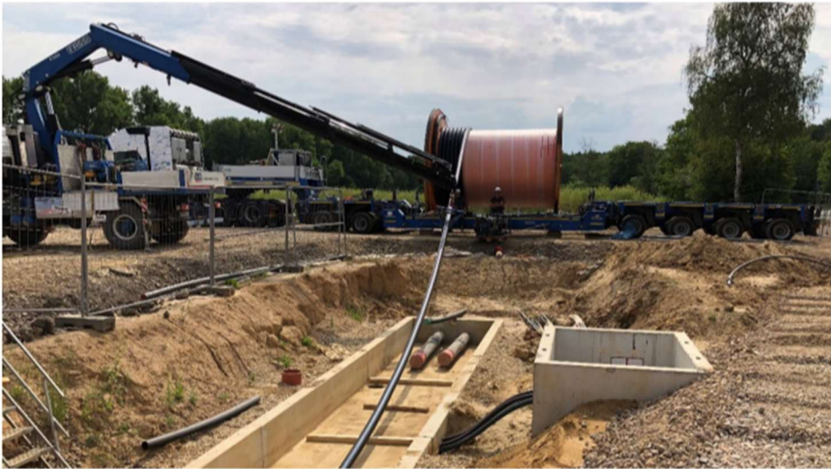
Abbildung 16: Beispiel für den Kabelzug am Spulenplatz, Quelle: Amprion GmbH
