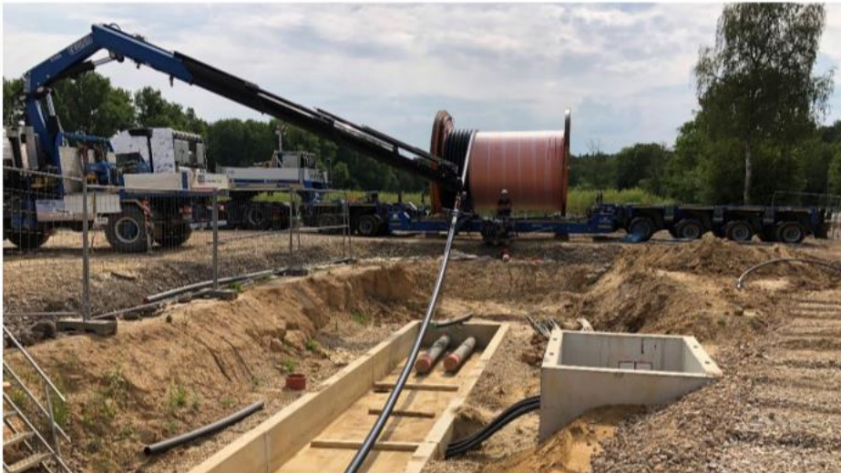
Abbildung 15: Beispiel für den Kabelzug am Spulenplatz, Quelle: Amprion GmbH
