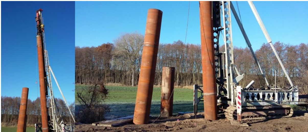
Abbildung 14: Errichtung Pfahlgründung
