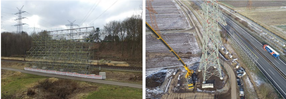
Abbildung 19: Schutzgerüste an Bahn- und Autobahnkreuzung
