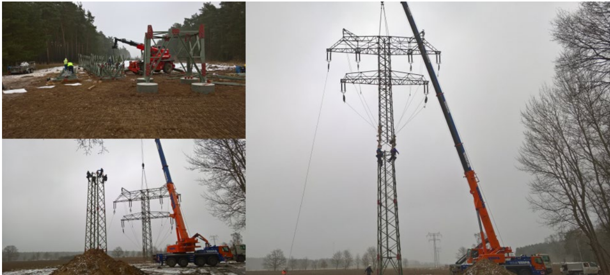
Abbildung 16: Maststocken mittels Mobilkran
