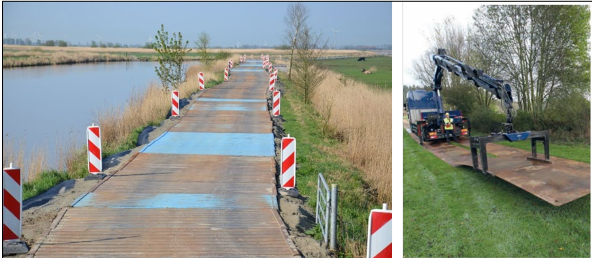
Abbildung 12: Provisorische Zuwegung und deren Errichtung
