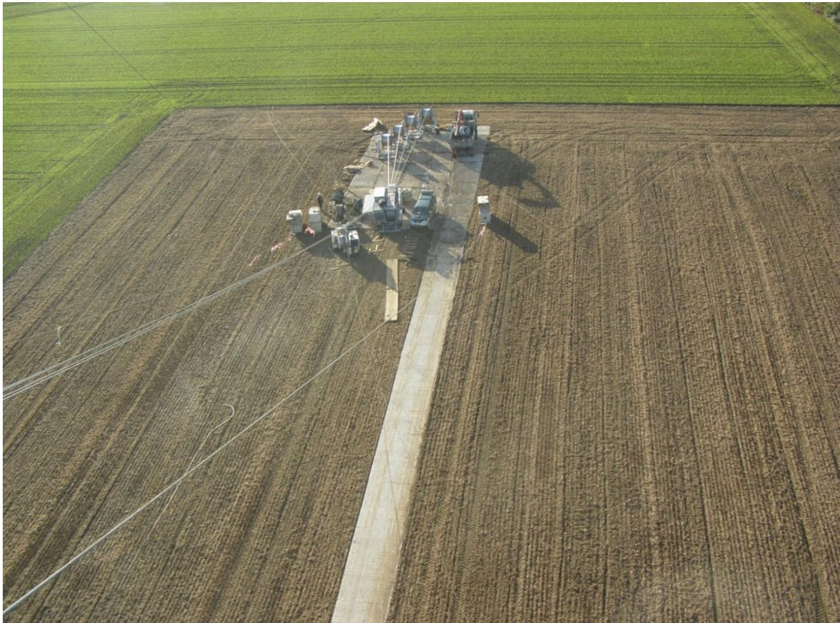
*Abbildung 26: Windenplatz eines 4er-Bündel-Seilzuges*
