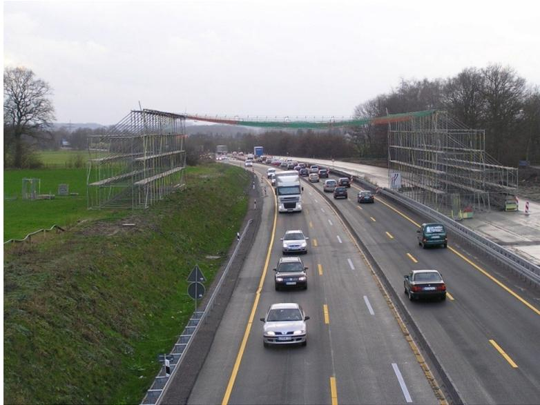
Abbildung 28: Stahlrohrkonstruktion mit Netz zum Schutz über einer Autobahn
