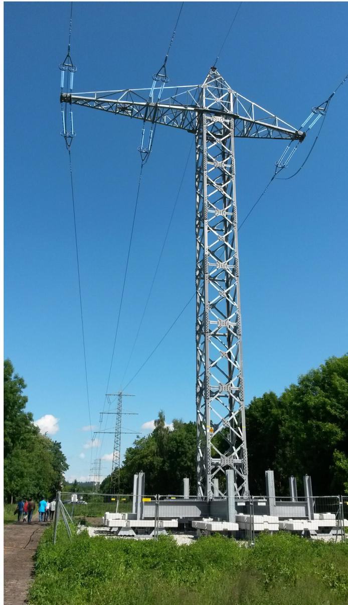
*Abbildung 29: Darstellung Freileitungsprovisorium*
