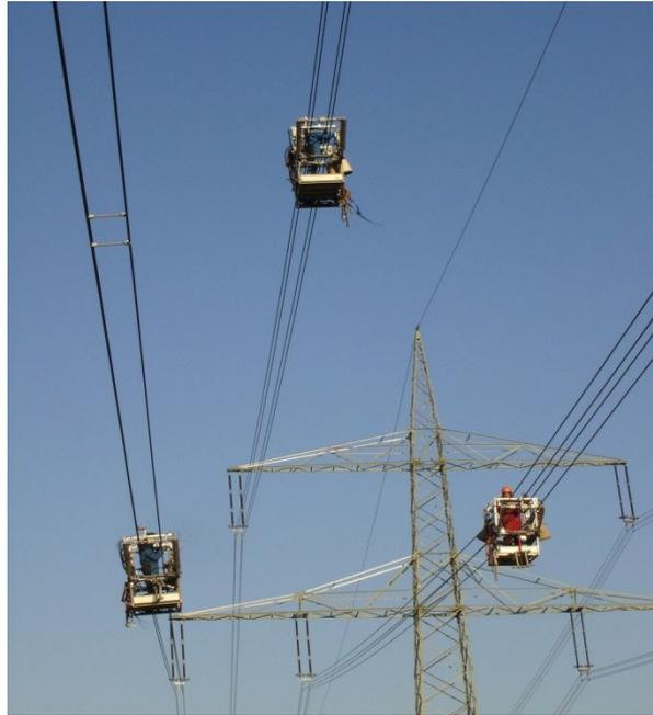
*Abbildung 27: Montage der Feldbündelabstandhalter mit Fahrwagen*
