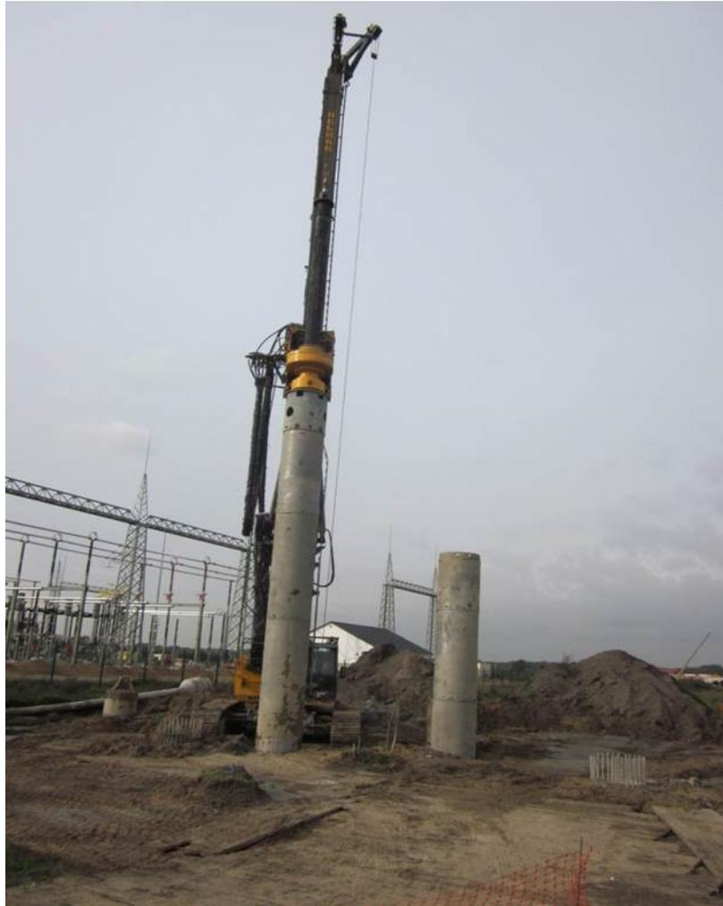
Abbildung 21: Bohrung für einen Bohrpfahl
