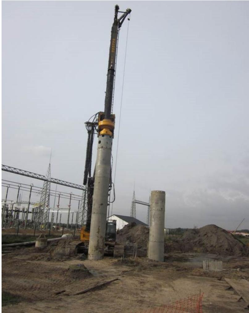
*Abbildung 16 Bohrung für ein Bohrpfahlfundament*
