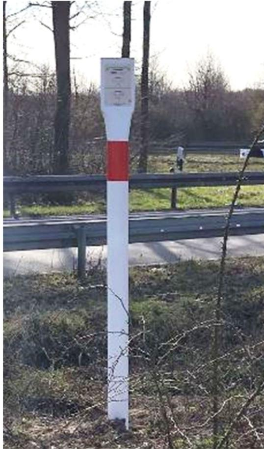
Abbildung 42 Schilderpfahl zur Markierung der Leitungstrasse (Quelle: Amprion)
