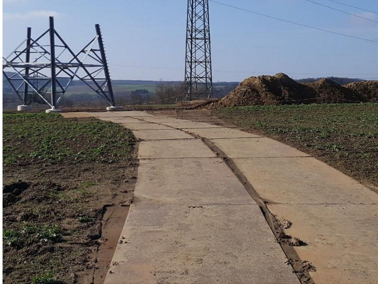
Abbildung 17: Temporäre Zuwegung über Fahrbohlen wie hier mit Stahlplatten
