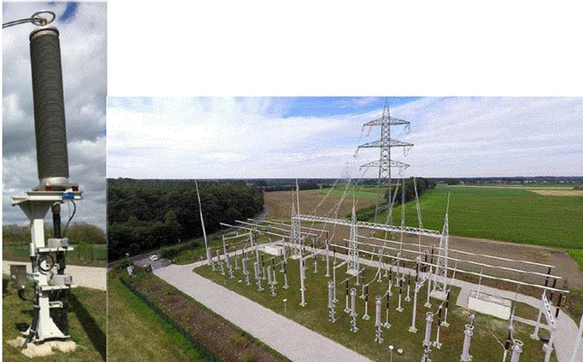
Abbildung 35: Kabelendverschluss und Portal (Beispiel)
