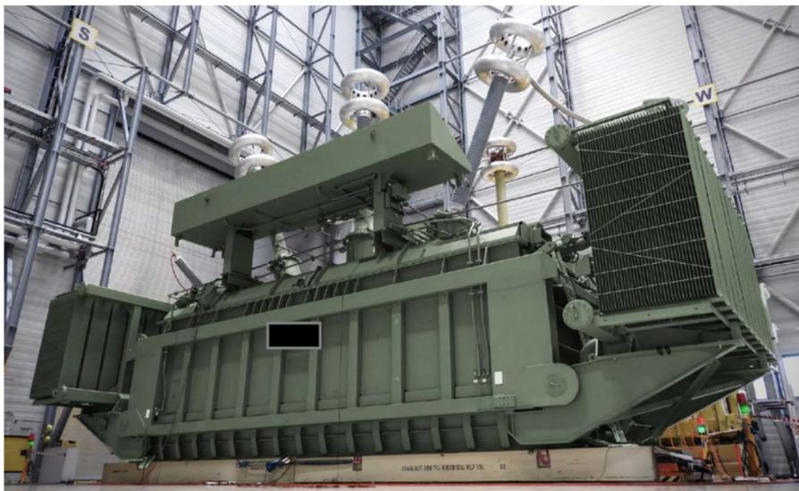
Abbildung 45 Beispiel für eine Drossel in einer Einhausung
