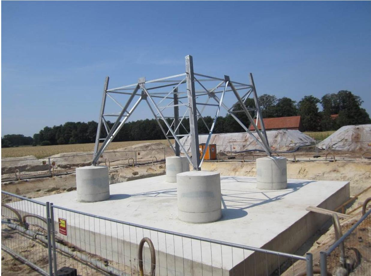
Abbildung 15: Plattenfundament
