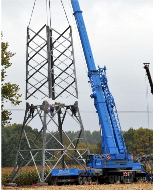
*Abbildung 23: Mastmontage (Stocken)*
