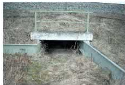
Abb. 24 Kleintierdurchlass mit Amphibienleiteinrichtung Fotos: J. Weber
