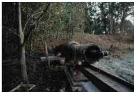
Abb. 23 Durchpressen des Straßenkörpers für eine Trockenröhre
