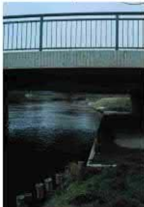
Abb. 21 Künstliche Berme aus Beton
