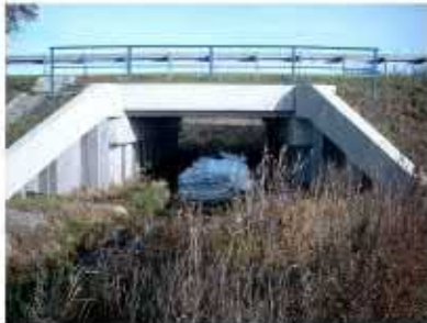
Abb.19 Weit überspannende Brücke
