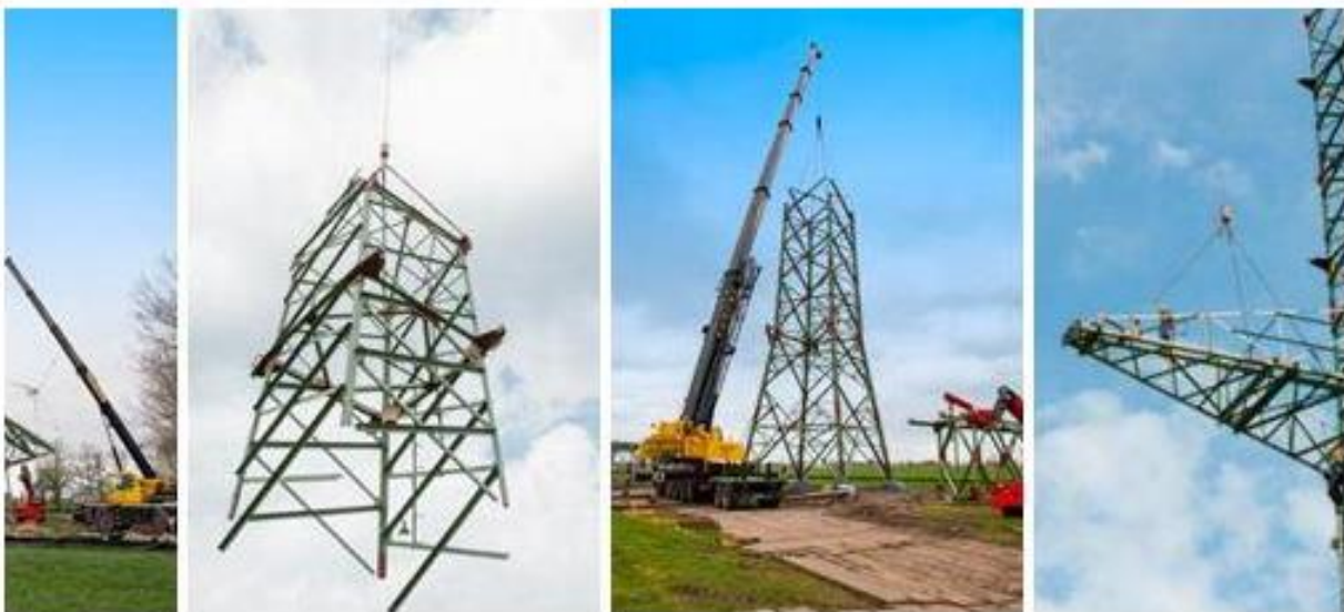
Abbildung 38: Stocken eines Freileitungsmastes (Quelle: Tennet TSO GmbH)
