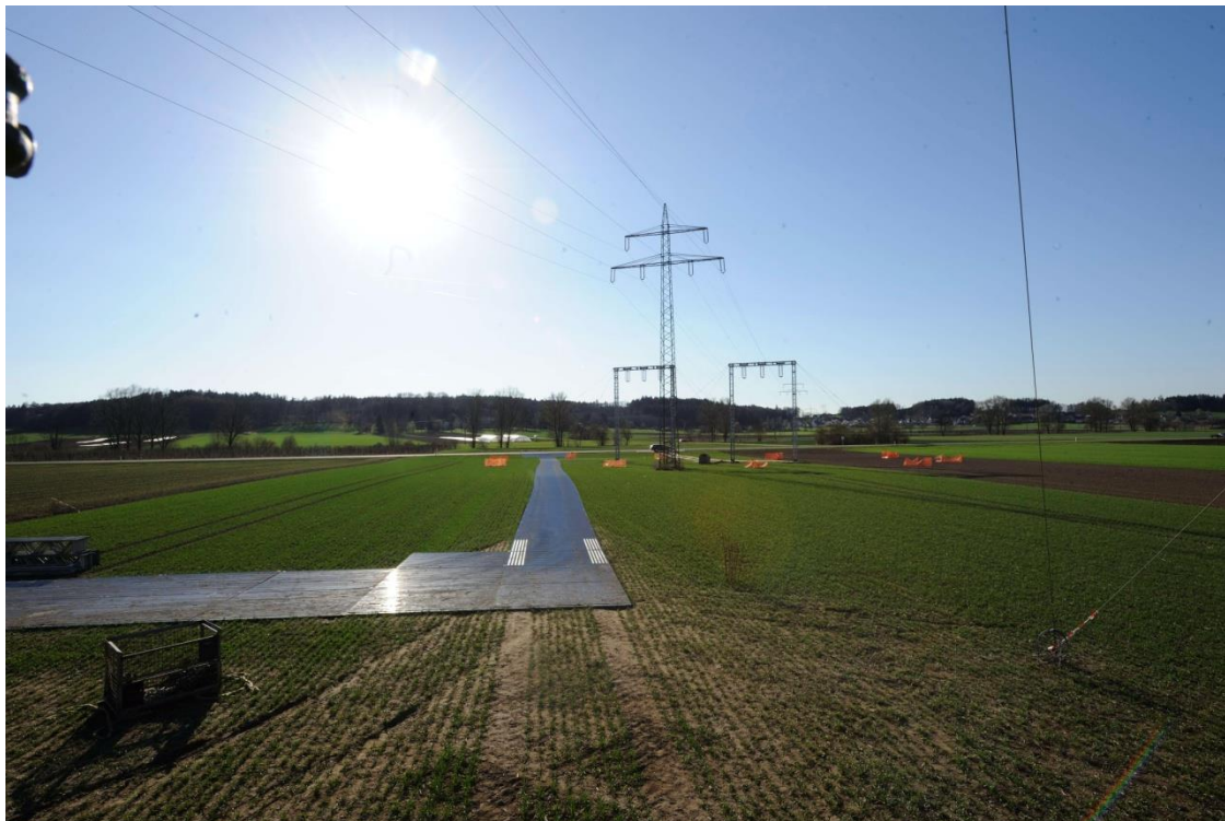
Abbildung 36: Provisorische Zuwegung als Plattenzufahrt bei einer Freileitungsbaustelle
