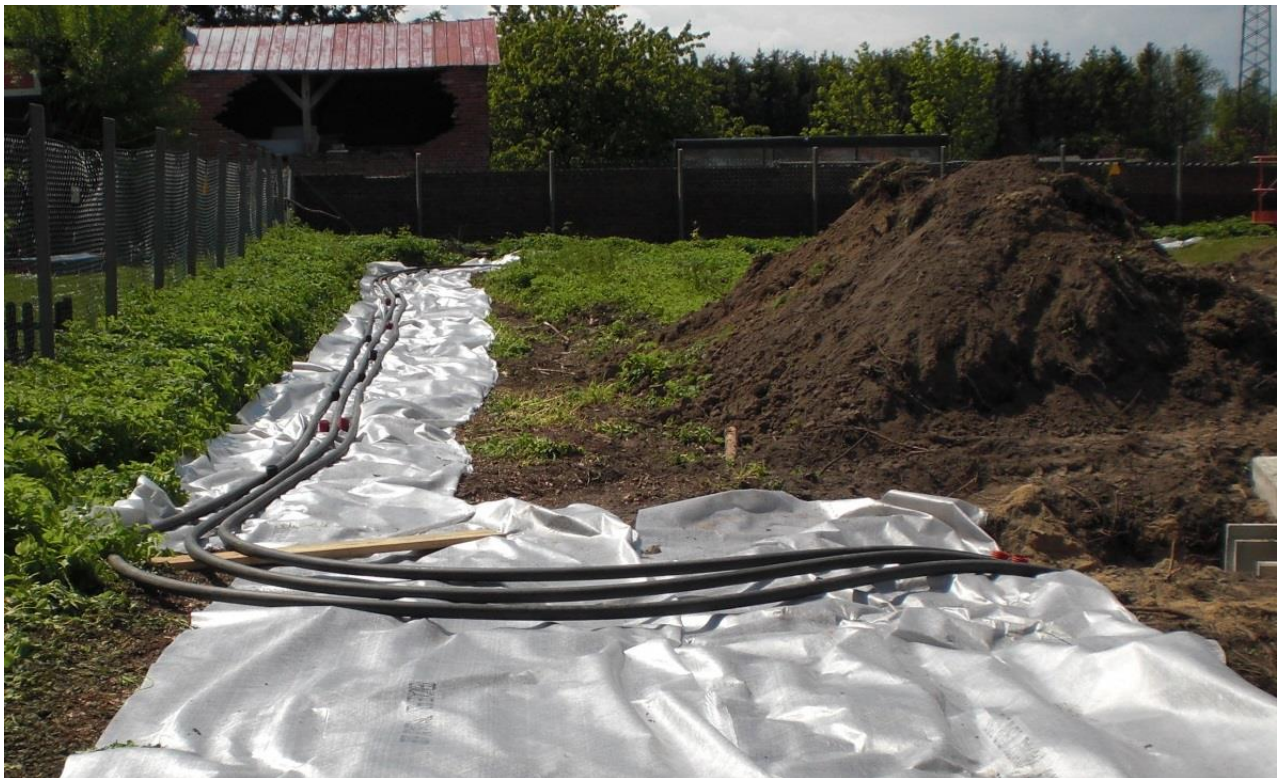
Abbildung 55: Baueinsatzkabel mit Schutzvlies-Unterlage (Quelle: SPIE SAG GmbH)
