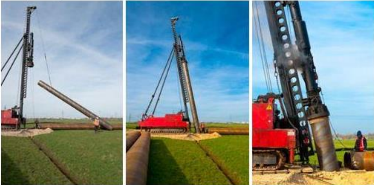
Abbildung 37: Pfahlgründung (Quelle: Tennet TSO GmbH)
