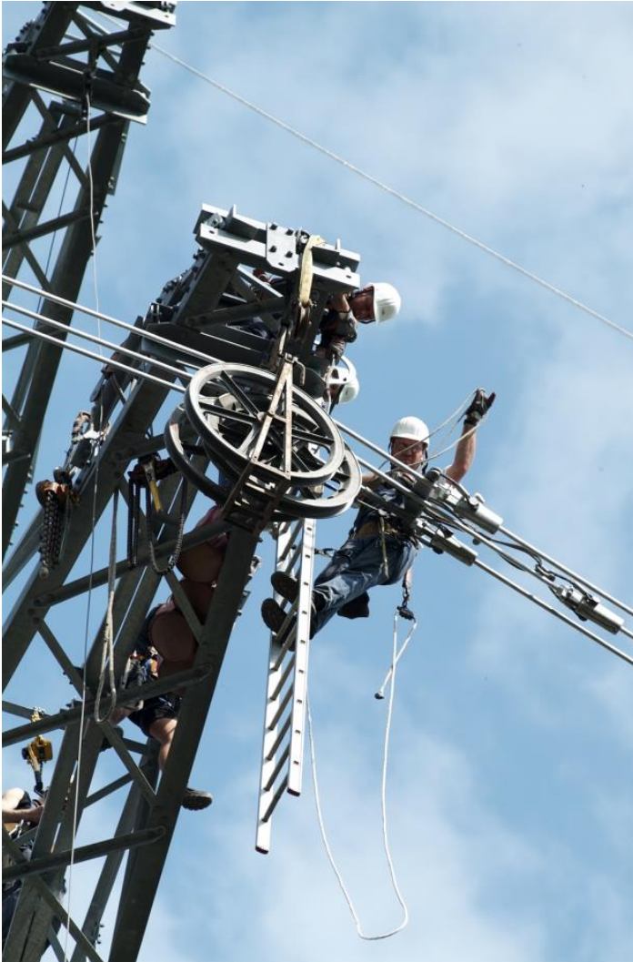
Abbildung 39: Seilzug (Quelle: TenneT TSO GmbH)
