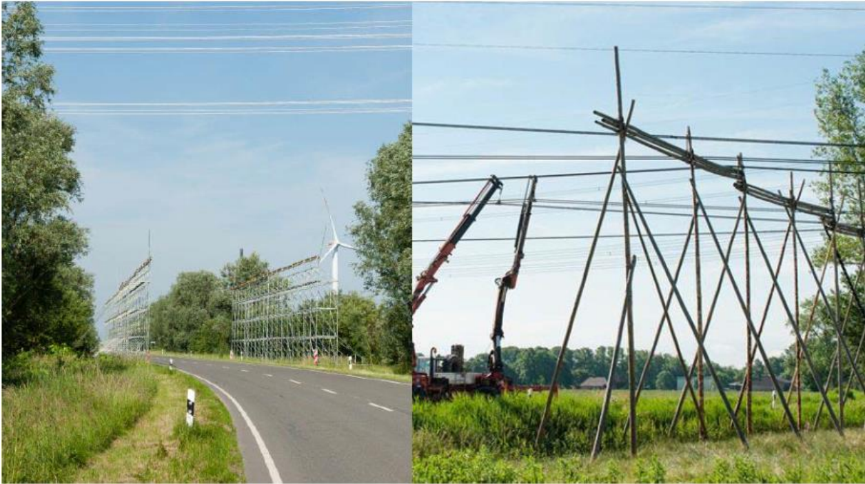
Abbildung 56: Beispiele für Schutzgerüste aus Stahl bzw. Holz
