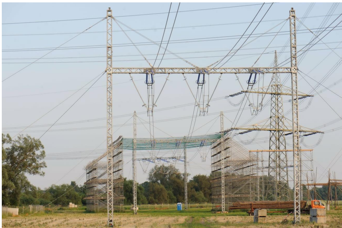
Abbildung 54: 380-kV-Freileitungsprovisorium für ein System, mit errichtetem Schutzgerüst
