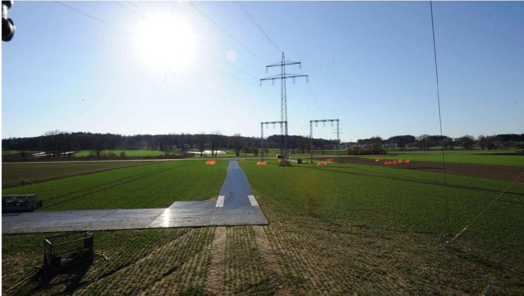
Abbildung 1: Provisorische Zuwegung als Plattenzufahrt bei einer Freileitungsbaustelle
