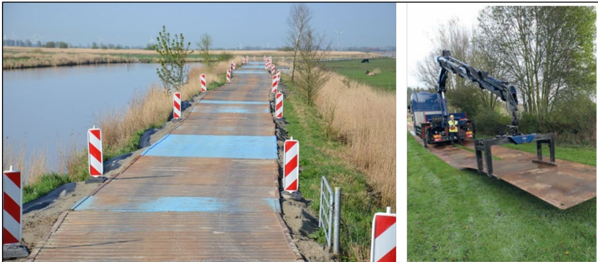
Abbildung 11: Provisorische Zuwegung und deren Errichtung
