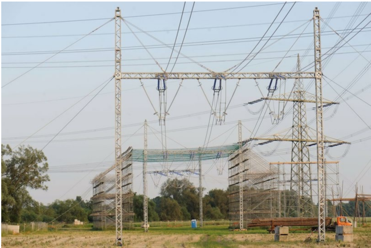
Abbildung 19: 380-kV-Freileitungsprovisorium für ein System mit errichtetem Schutzgerüst
