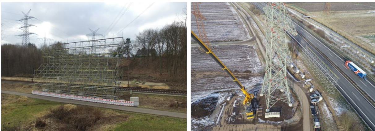
Abbildung 18: Schutzgerüste an Bahn- und Autobahnkreuzung
