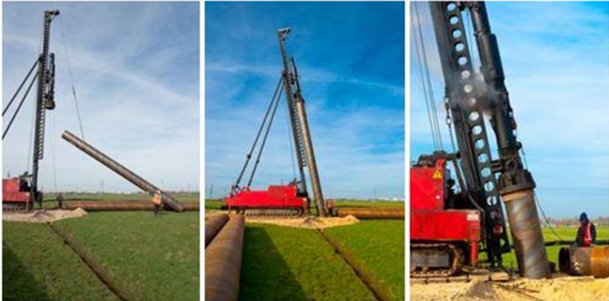
Abbildung 13: Errichtung Pfahlgründung
