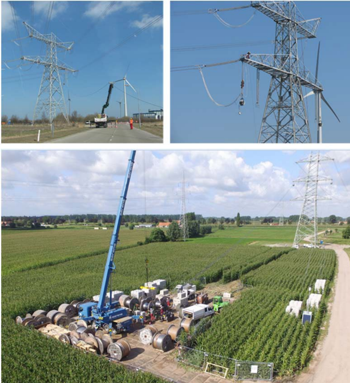
Abbildung 17: Seilzug und Seilmontage
