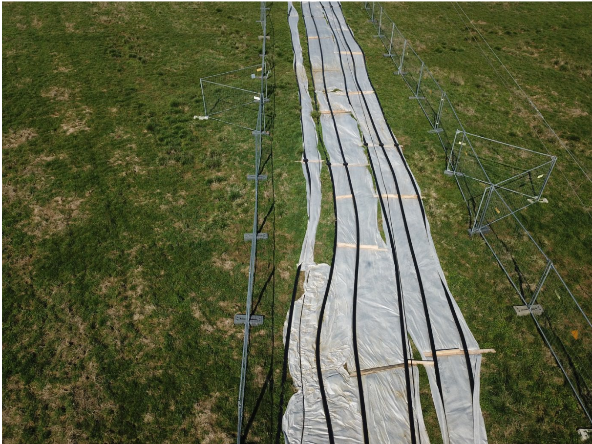
Abbildung 20: Beispiel für ein Baueinsatzkabel einer zweisystemigen Freileitung
