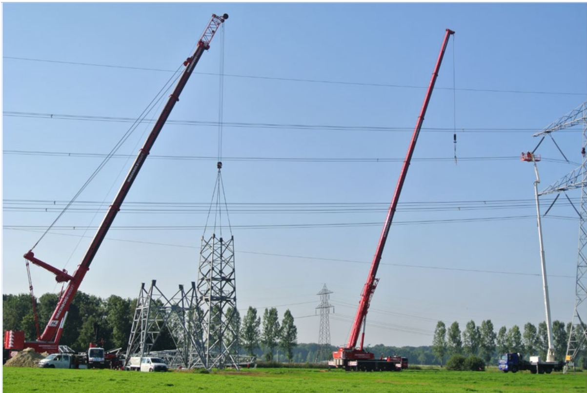
Abbildung 15: Maststocken mittels Mobilkran
