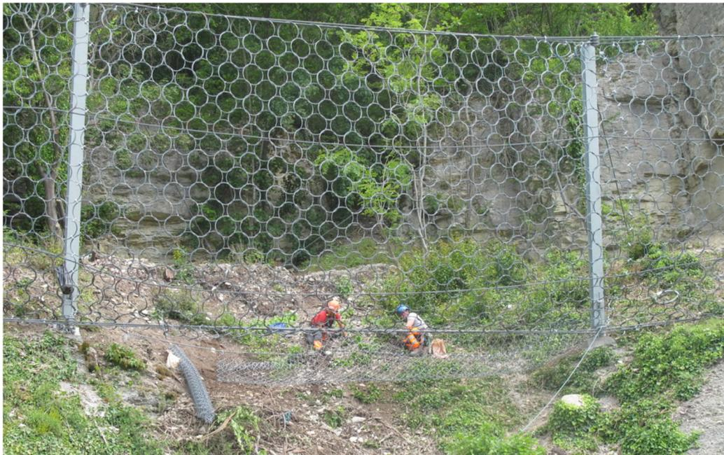
Die Fangzäune müssen unten verschlossen und dem Gelände angepasst werden.
