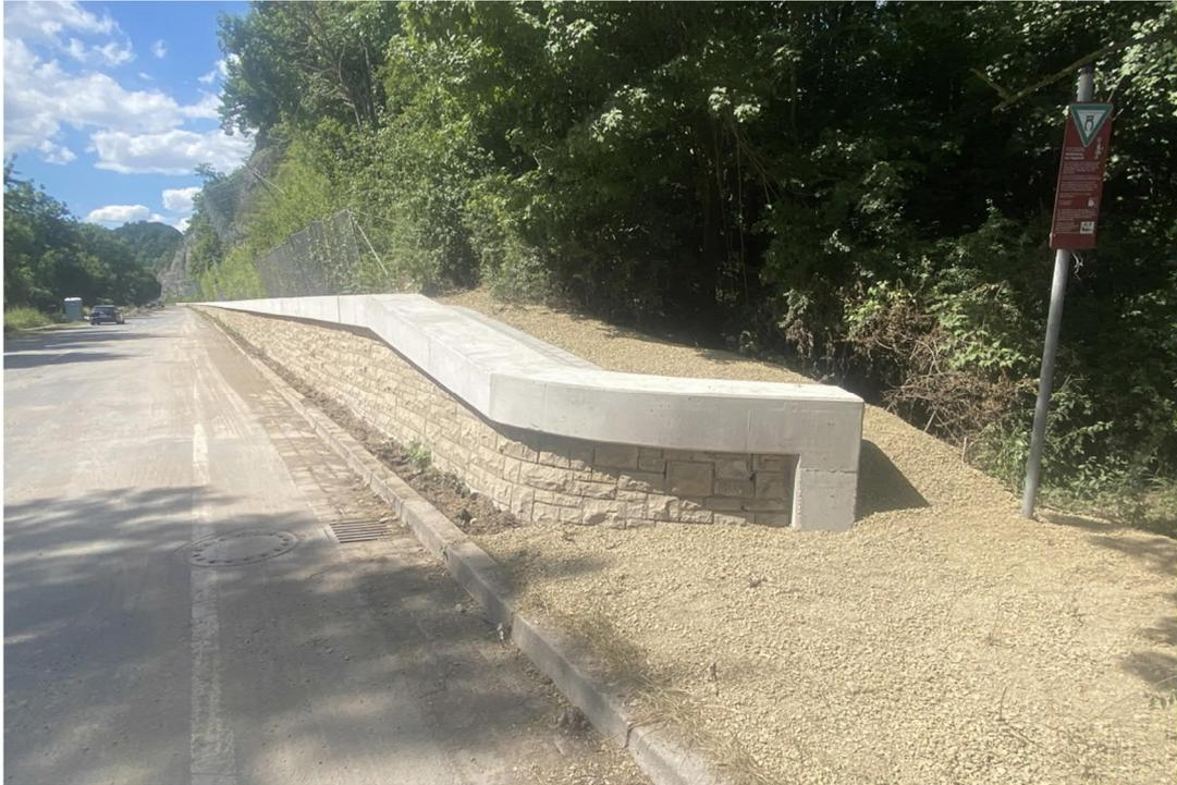
Die Stützmauer ist mittlerweile fertig saniert. Lediglich die Fugen sind noch nachzuarbeiten.
