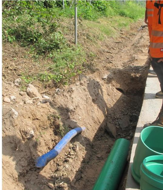
Die Entwässerung ist in einigen Abschnitten nicht mehr funktionstüchtig und muss erneuert werden.
