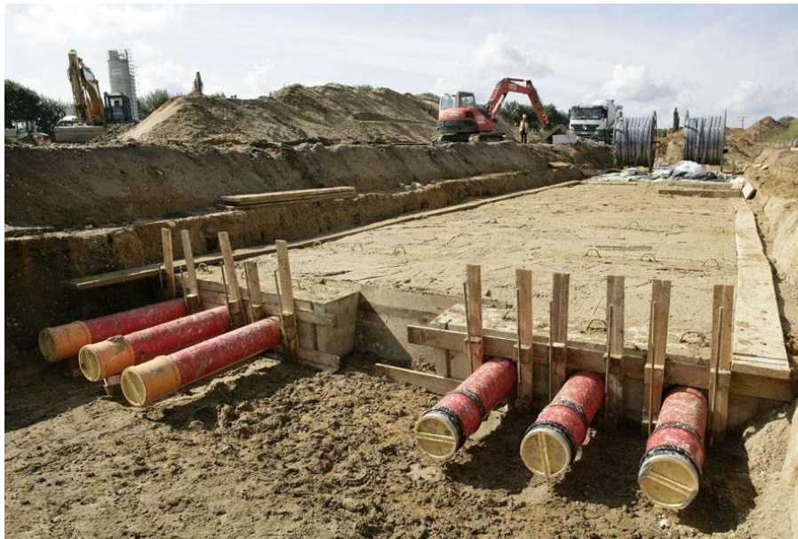
Abbildung 36: Verfestigter zeitweise fließfähiger selbstverdichtender Verfüllbaustoff (ZFSV)
