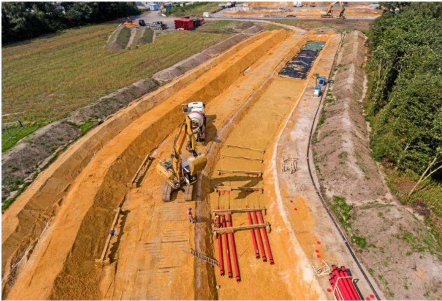
Abbildung 34: Herstellung eines Rohrgrabens und Leitungsverlegung
