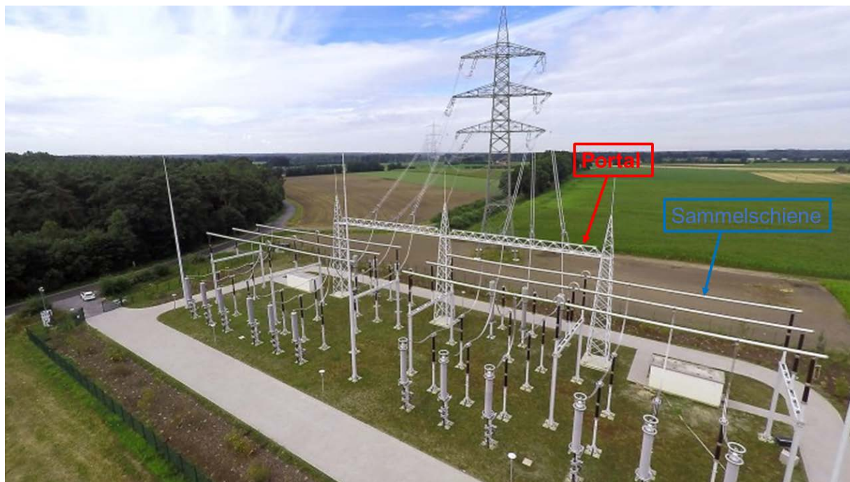
Abbildung 44: Technische Elemente KÜS (roter Pfeil Portale und blauer Pfeil Sammelschiene)
