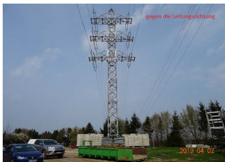
Abbildung 15: Beispielhafte Darstellung eines Freileitungsprovisoriums mit Auflastfundamenten
