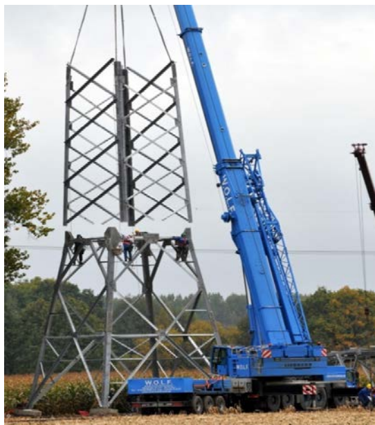
Abbildung 21: Mastmontage (Stocken)
