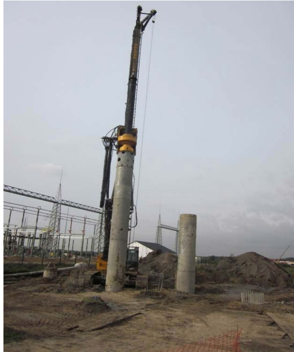
Abbildung 18: Bohrung für einen Bohrpfahl
