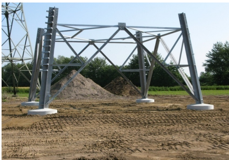
Abbildung 20: Montierter Mastfuß
