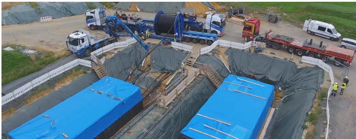
Abbildung 38: Muffengrube mit bauzeitlicher Einhausung
