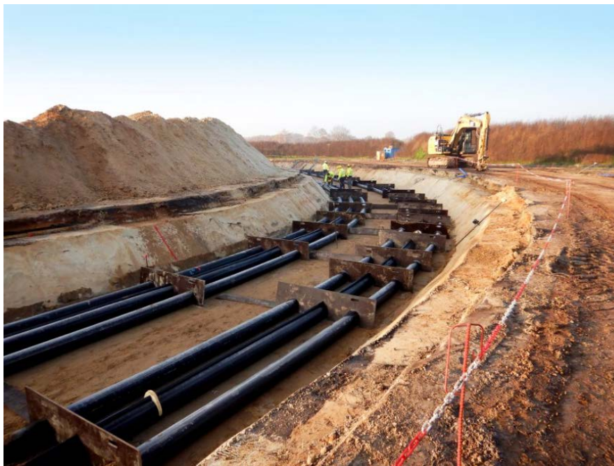
Abbildung 35: Positionierung Schutzrohre und Auftriebssicherung
