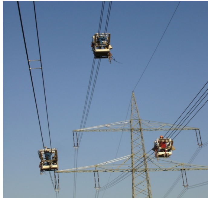
Abbildung 25: Montage der Feldbündelabstandshalter mit Fahrwagen
