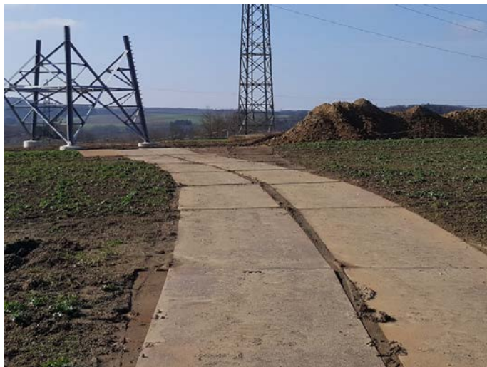
Abbildung 16: Temporäre Zuwegung über Stahlplatten
