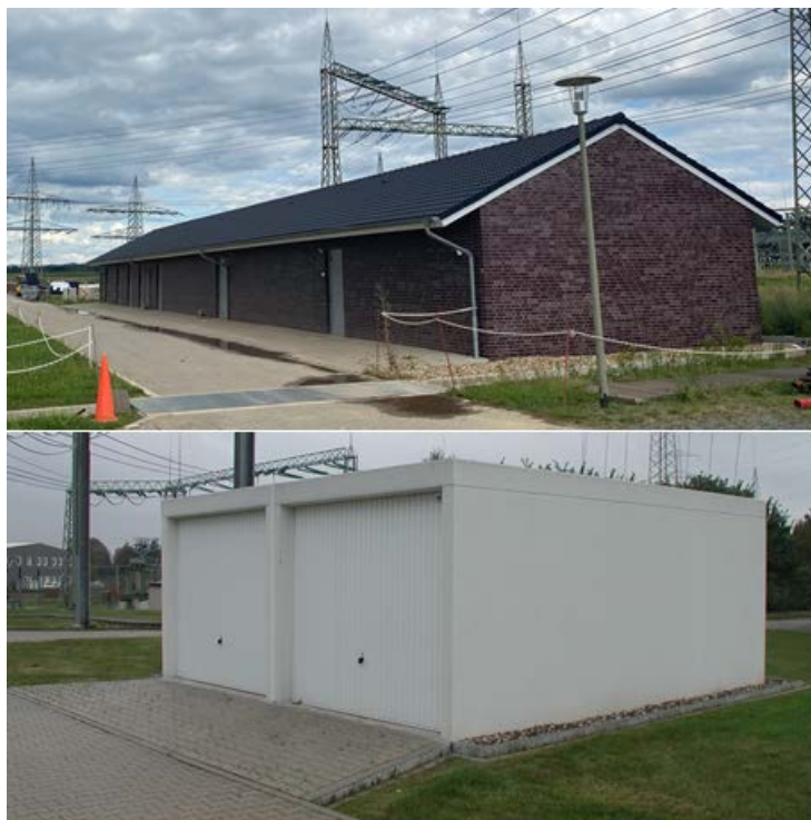
Abbildung 46: Lager (unten) und Betriebsgebäude (oben) einer KÜS
