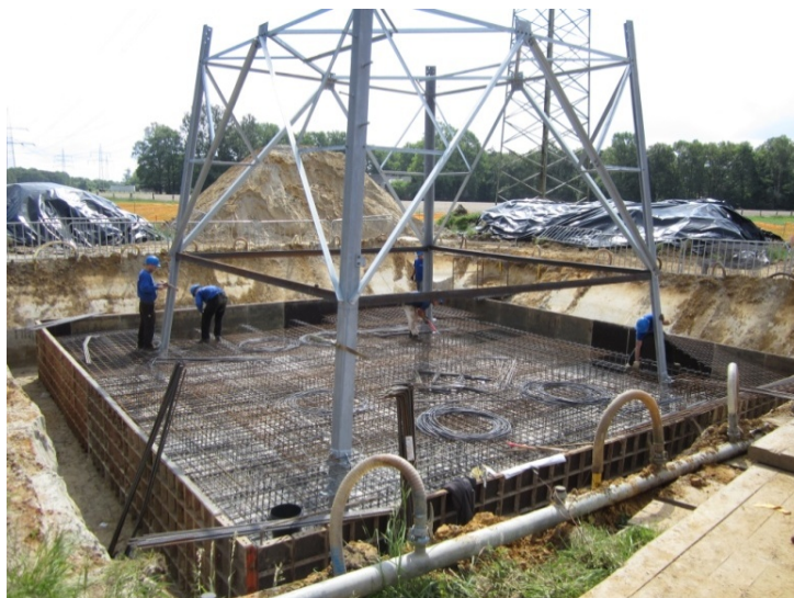
Abbildung 19: Montage der Fundamentbewehrung für ein Plattenfundament
