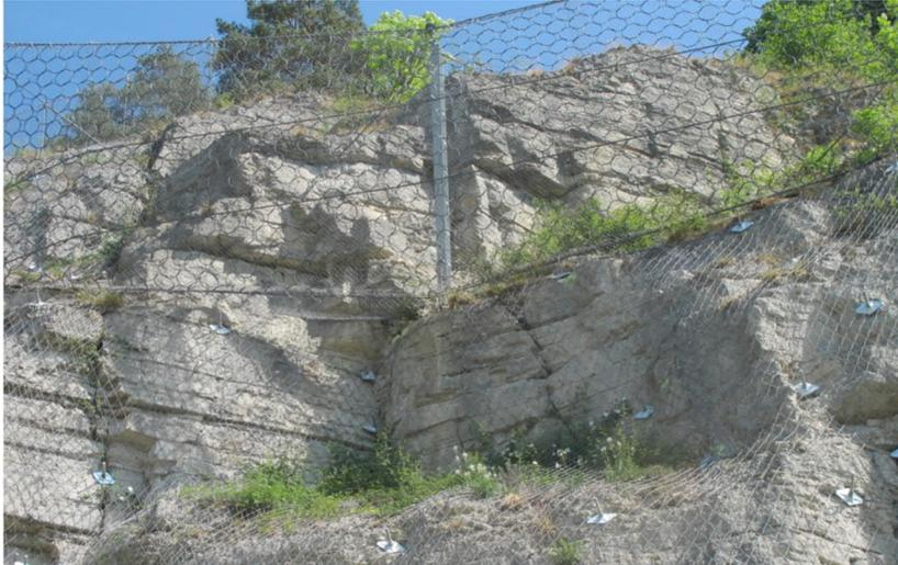
Durch Witterungseinflüsse, wie beispielsweise Temperaturwechsel zwischen Tag und Nacht, lösen sich immer wieder Gesteinsbrocken. Ein Herabfallen auf die Straße wird durch die Fangzäune verhindert.
