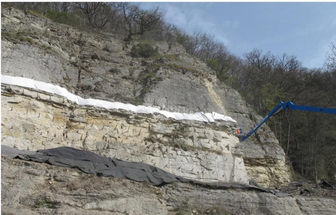
Aktuell wird auch an der Sanierung der 450 m langen Stützmauer in den nördlichen Abschnitten gearbeitet. Sie erhält einen neuen Kopfbalken als Abdeckung.
