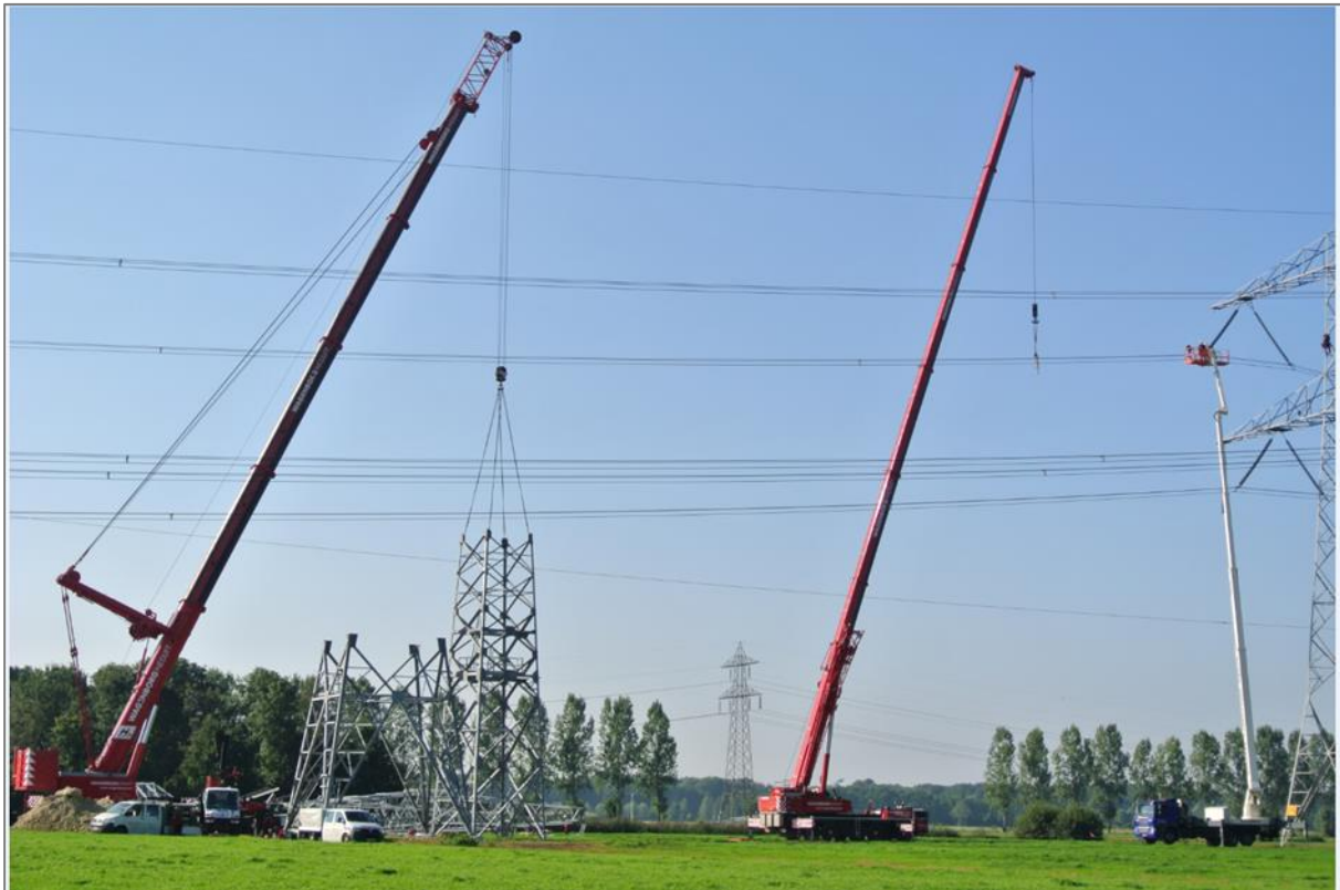
Abbildung 15: Maststocken mittels Mobilkran
