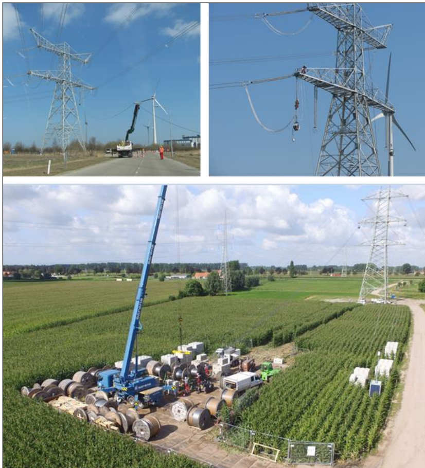
Abbildung 17: Seilzug und Seilmontage
