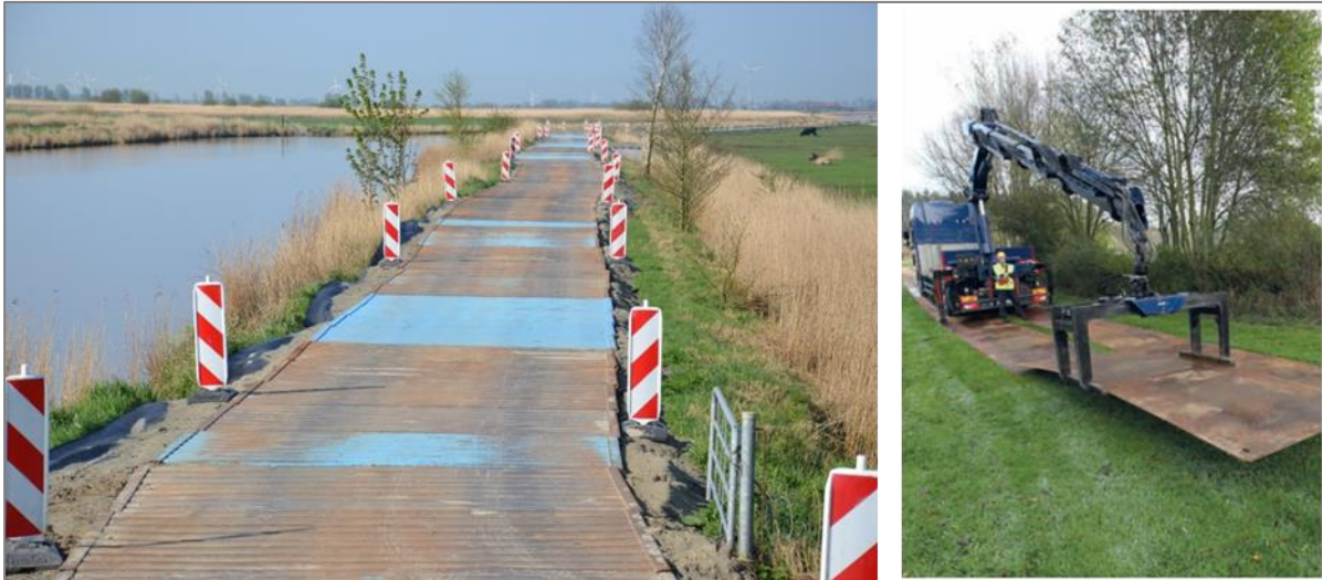
Abbildung 11: Provisorische Zuwegung und deren Errichtung
