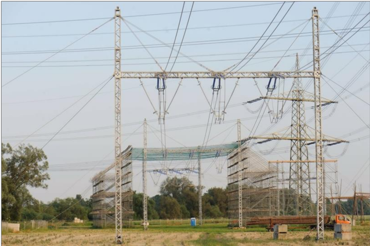
Abbildung 20: 380-kV Freileitungsprovisorium für ein System mit errichtetem Schutzgerüst
