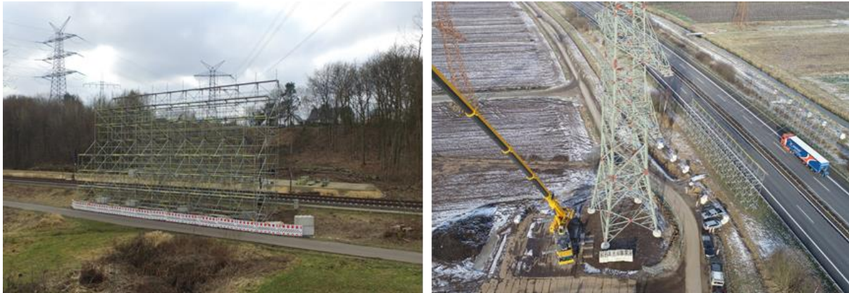
Abbildung 18: Schutzgerüste an Bahn- und Autobahnkreuzung
