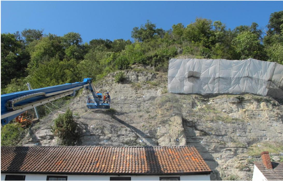
Die einzelnen Fangzäune haben Höhen bis zu 5 m, was angesichts der Dimensionen des Hanges nicht direkt deutlich wird. Auf den nachfolgenden Bildern werden die Höhen jedoch greifbar.
