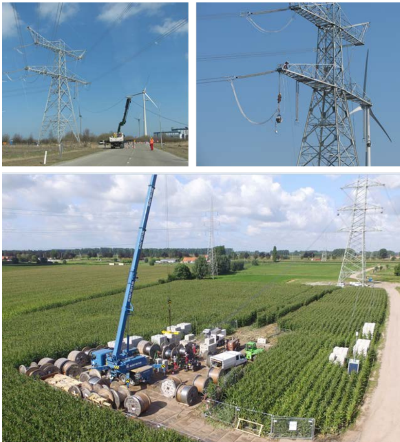
Abbildung 16: Seilzug und Seilmontage
