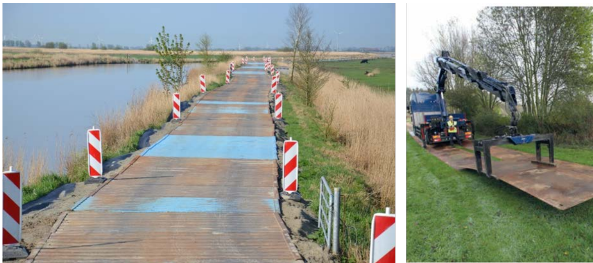
Abbildung 10: Provisorische Zuwegung und deren Errichtung
