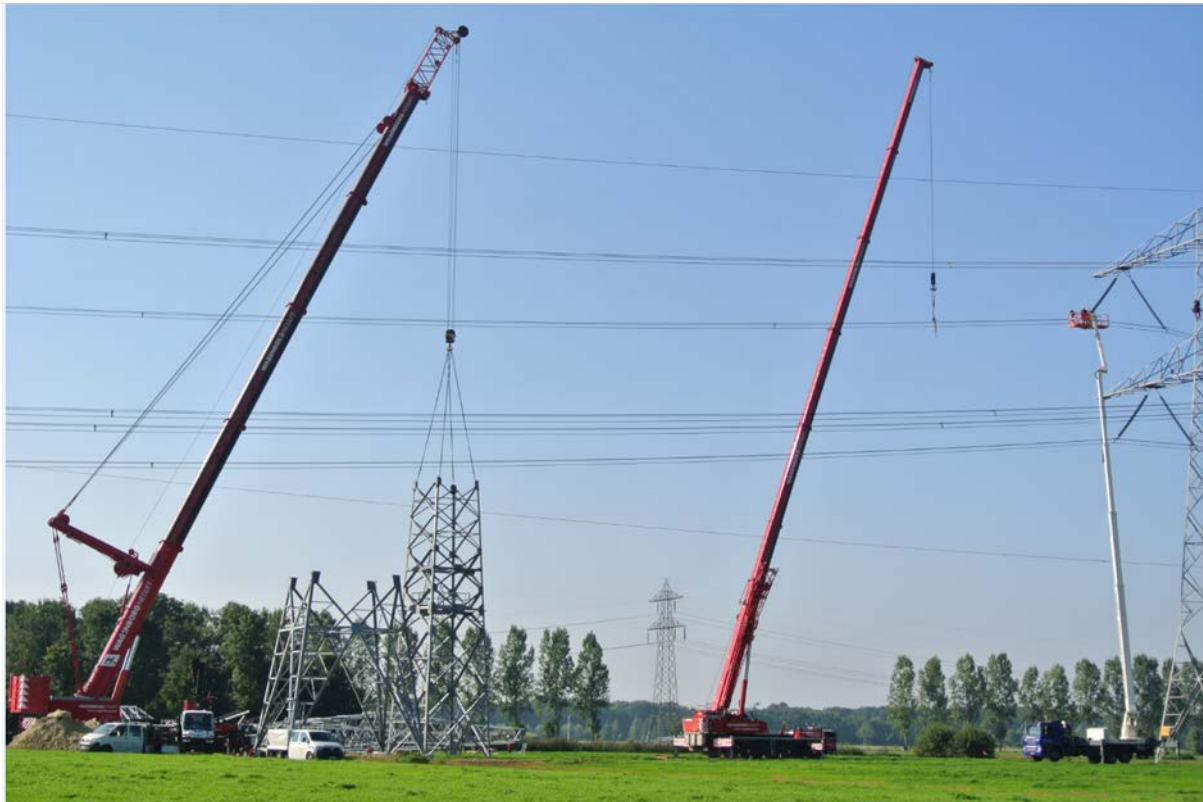
Abbildung 14: Maststocken mittels Mobilkran
