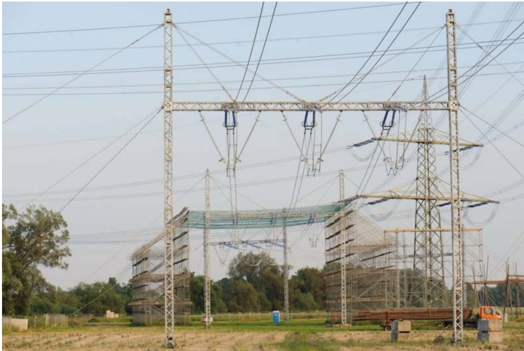
Abbildung 19: 380-kV Freileitungsprovisorium für ein System mit errichtetem Schutzgerüst
