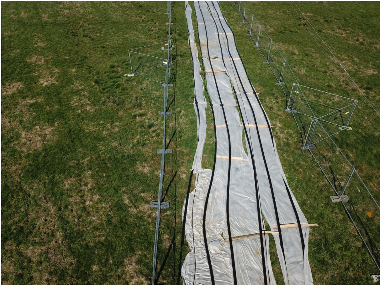
Abbildung 18: Beispiel für ein Baueinsatzkabel einer zweisystemigen Freileitung
