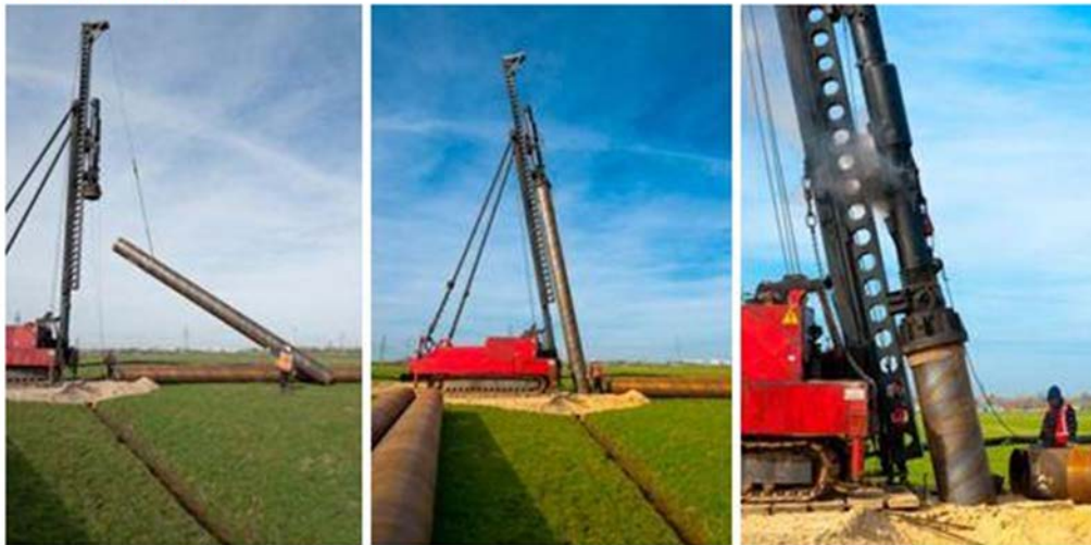
Abbildung 12: Errichtung Pfahlgründung
