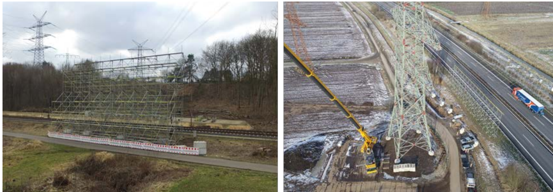
Abbildung 17: Schutzgerüste an Bahn- und Autobahnkreuzung
