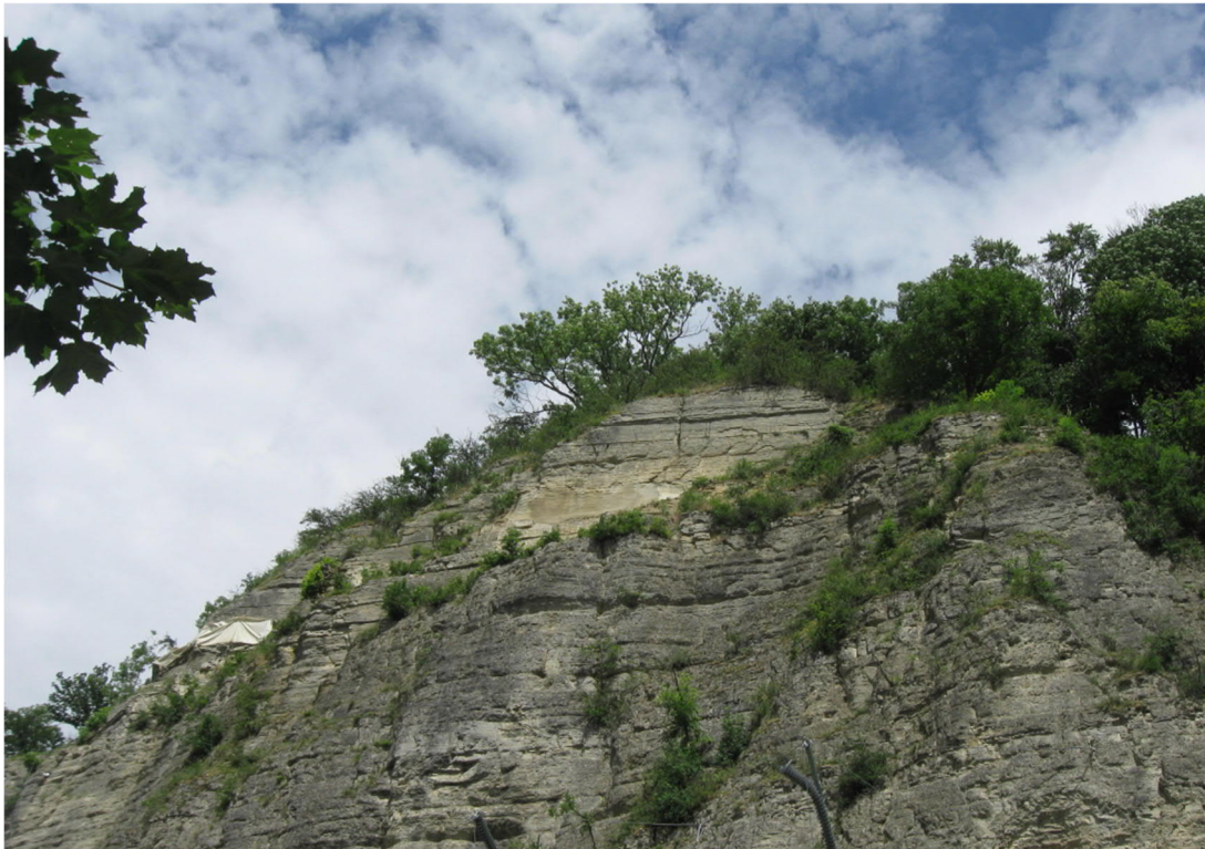
Hier ist eine fertig gestellt Spritzbetonsicherung zu sehen.
