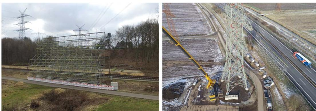
**Abbildung 18: Schutzgerüste an Bahn- und Autobahnkreuzung**
