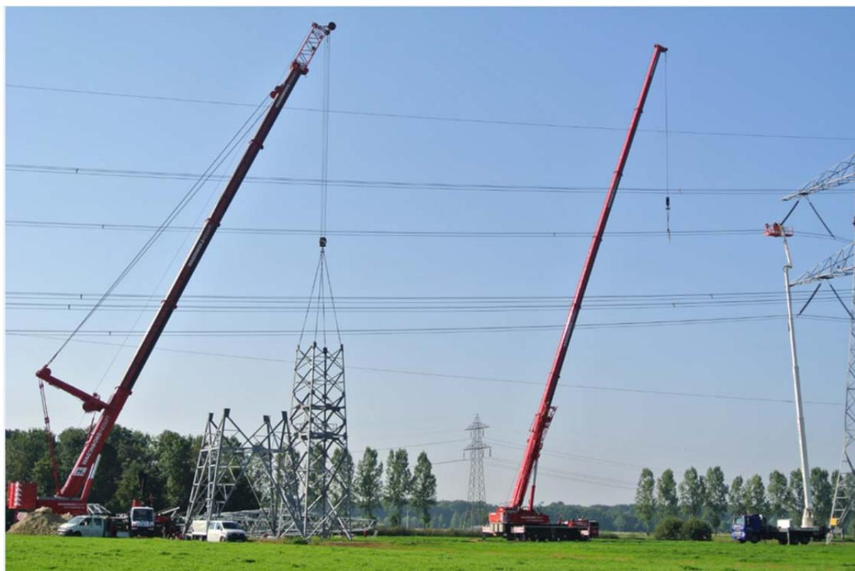
Abbildung 15: Maststocken mittels Mobilkran
