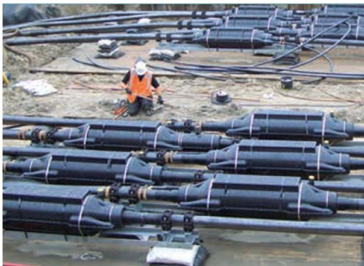
**Abbildung 24: Muffengraben im Bau**
