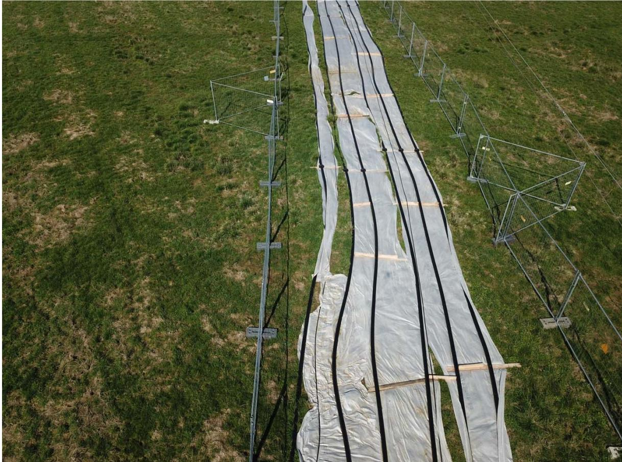
**Abbildung 19: Beispiel für ein Baueinsatzkabel einer zweisystemigen Freileitung**
