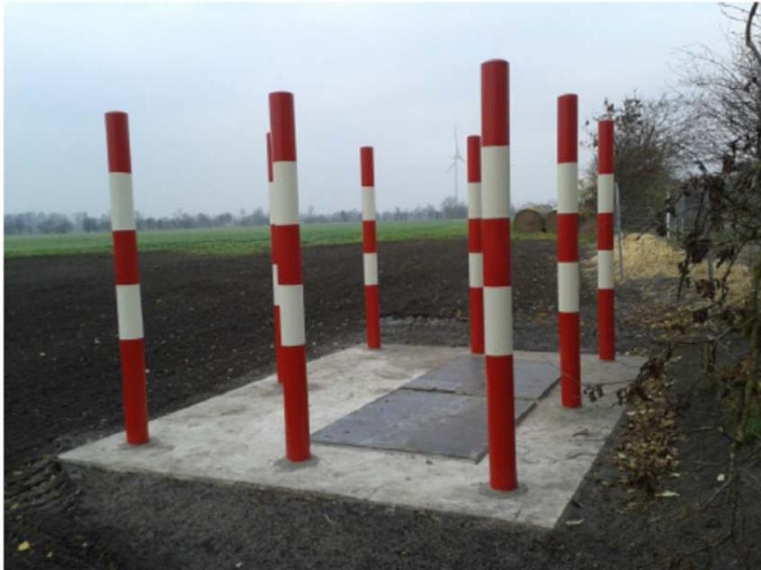
Abbildung 23: Cross-Bonding-Kästen in der Betriebsphase
