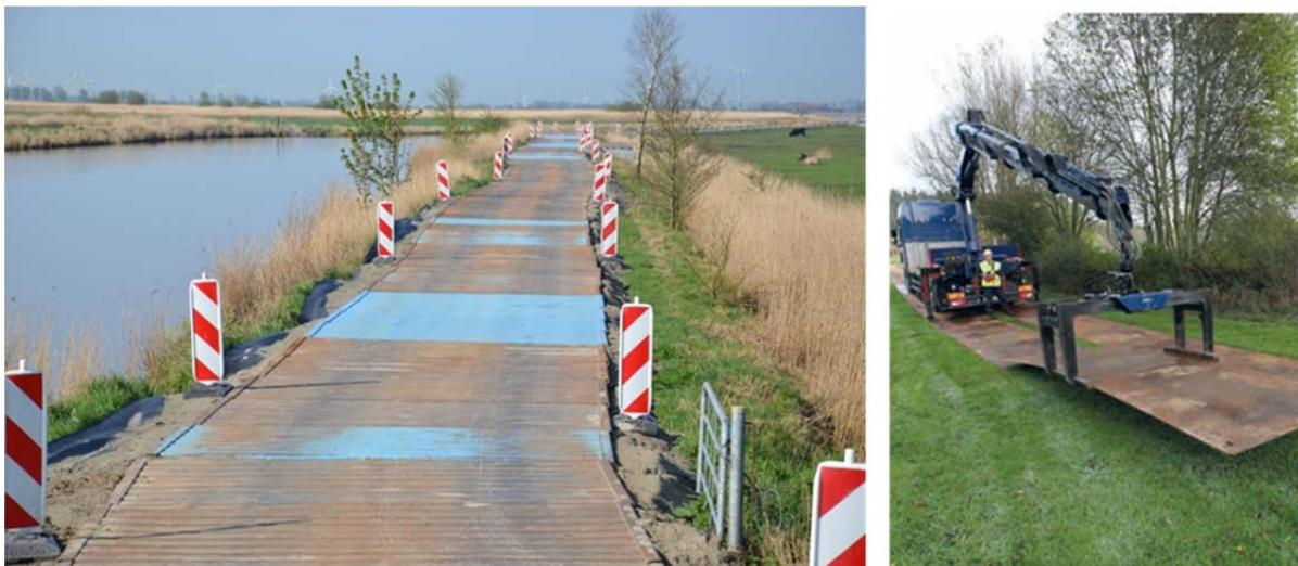
**Abbildung 11: Provisorische Zuwegung und deren Errichtung**
