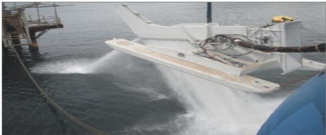
Abbildung 53: Ein Düsenschlitten mit eingeschalteten Düsen (Cimolai Technology spa).
