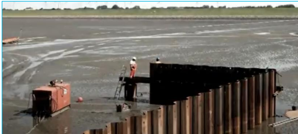
Abbildung 57: Zielgrube mit Spundwand.
