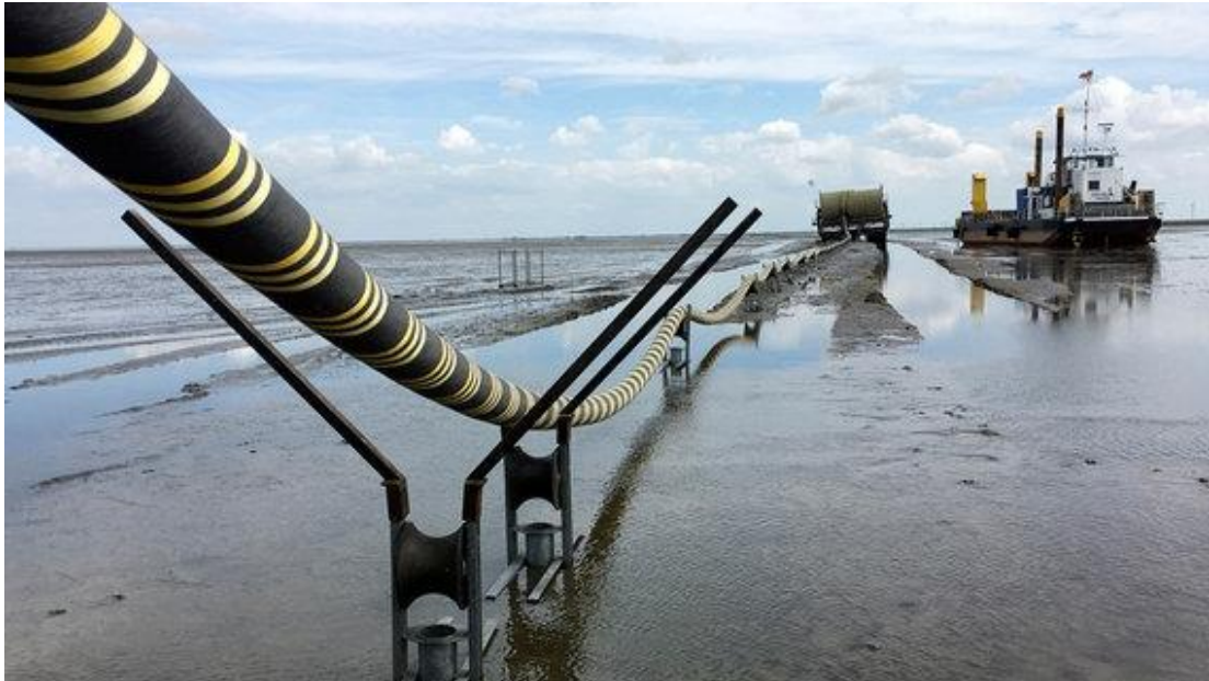
Abbildung 49: Rollenbahn zum Einziehen des Kabelbündels.
