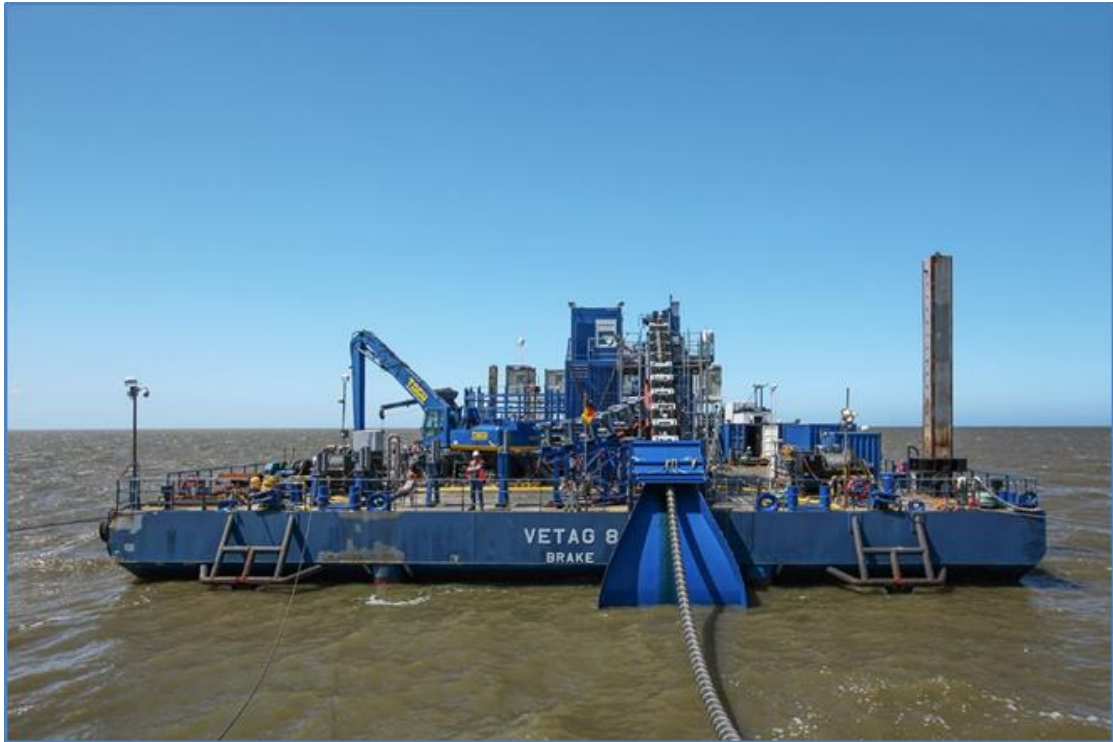
Abbildung 48: Flachwasser-Kabellegung durch eine Barge (mit freundlicher Genehmigung von Gemini Windpark).
