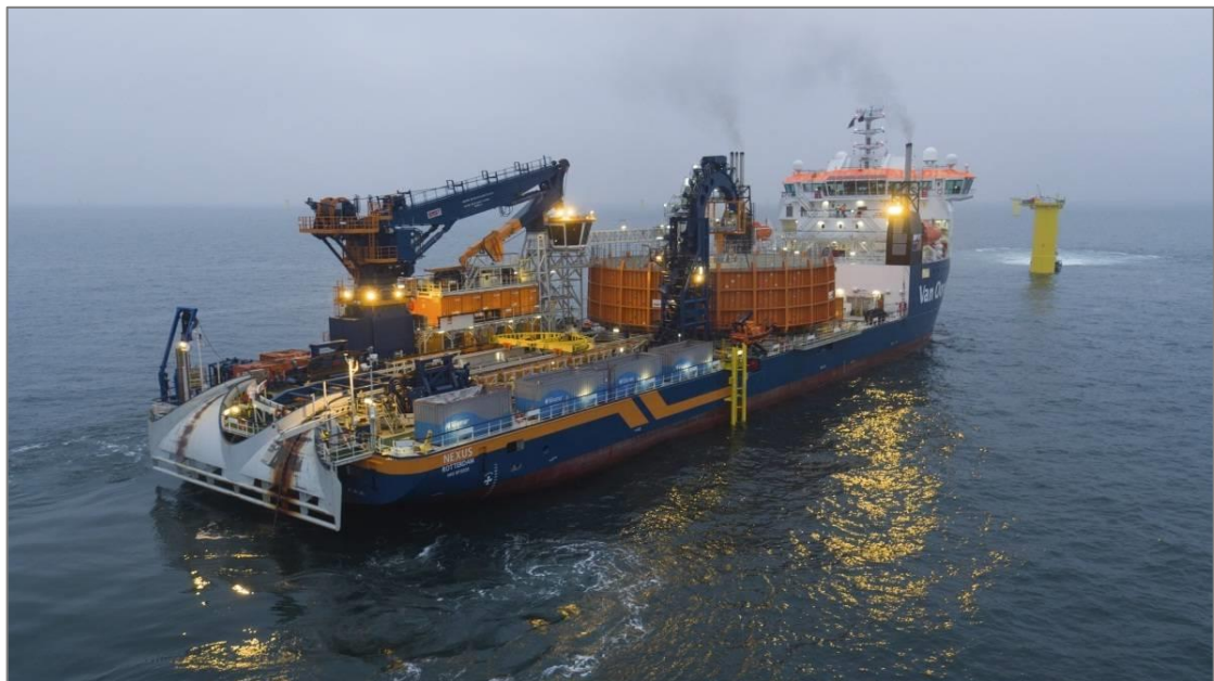
Abbildung 47: Kabellegeschiff (mit freundlicher Genehmigung von Van Oord Marine Contractors).
