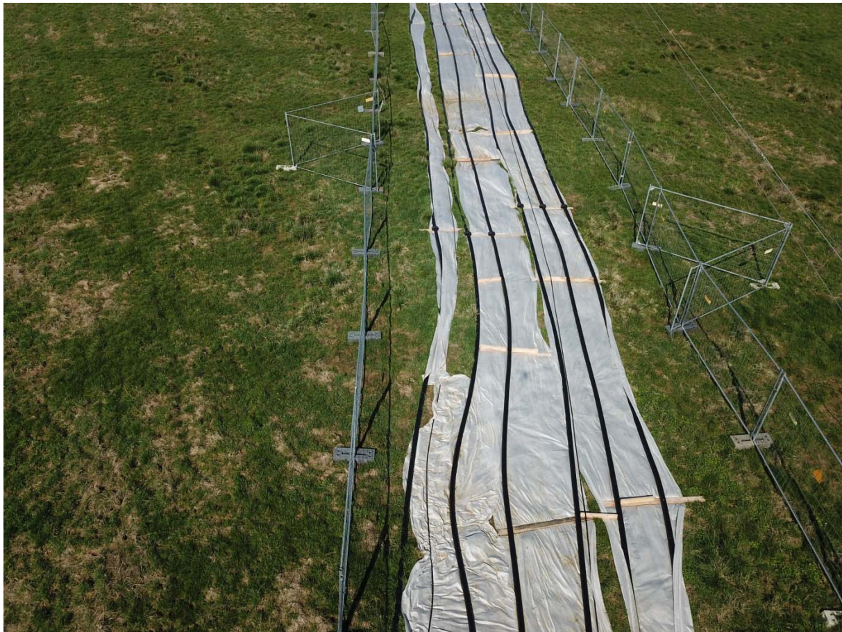
Abbildung 19: Beispiel für ein Baueinsatzkabel einer zweisystemigen Freileitung
