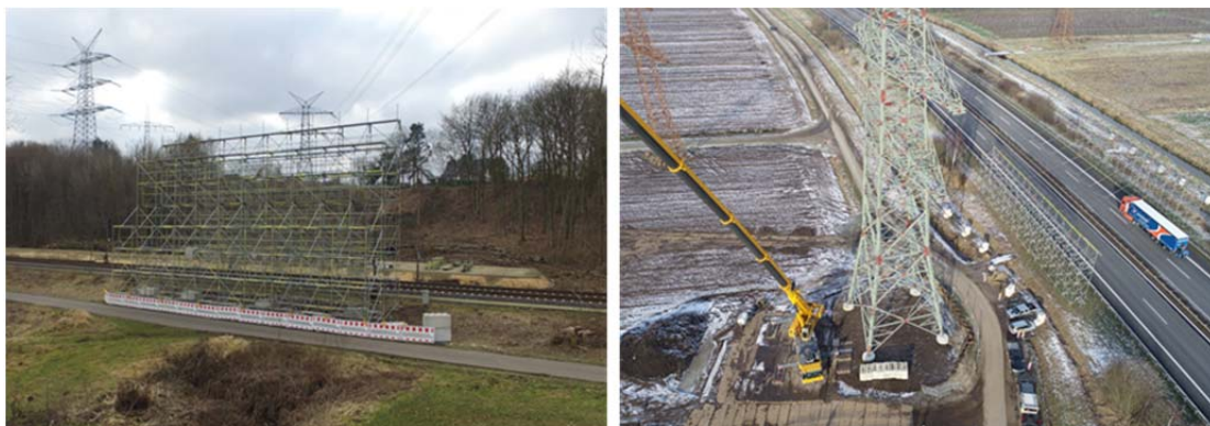
Abbildung 18: Schutzgerüste an Bahn- und Autobahnkreuzung
