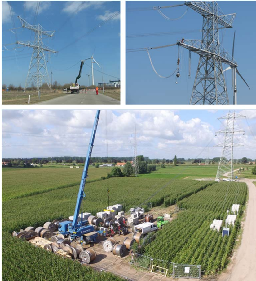
Abbildung 17: Seilzug und Seilmontage
