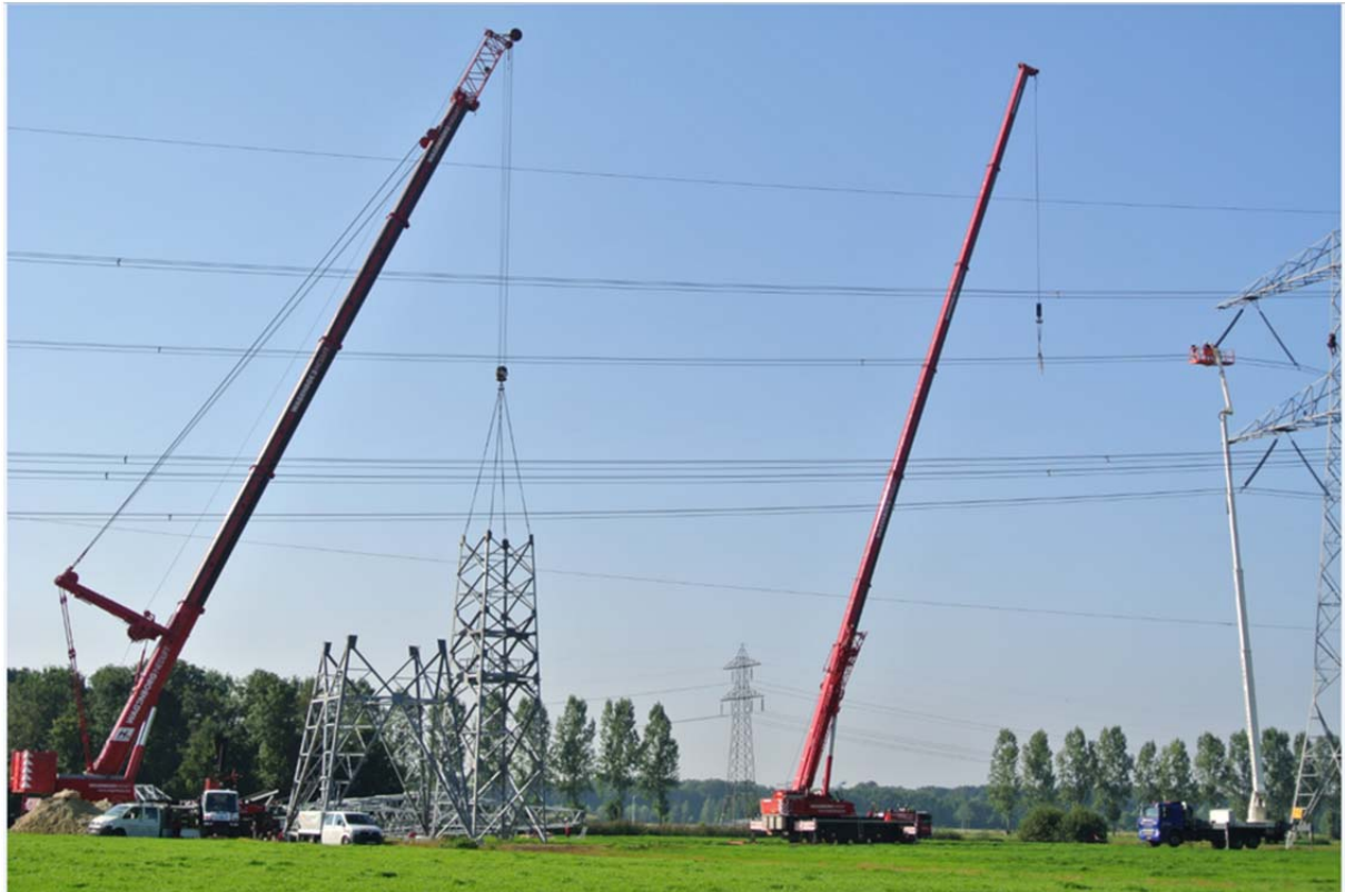
Abbildung 15: Maststocken mittels Mobilkran
