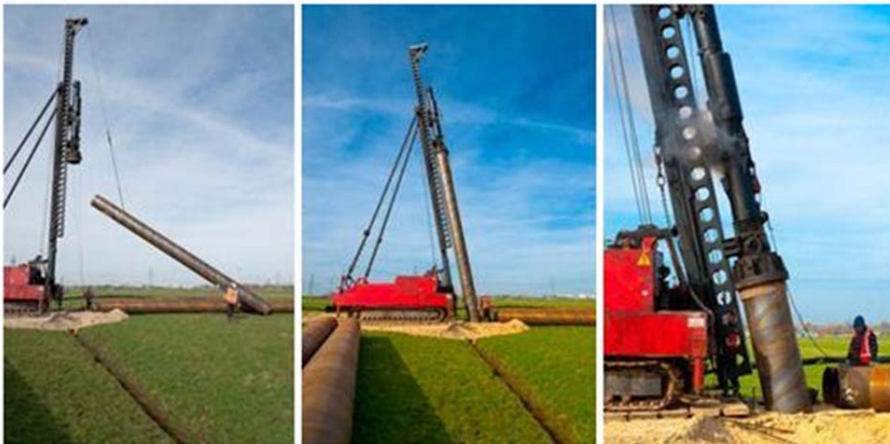
Abbildung 13: Errichtung Pfahlgründung
