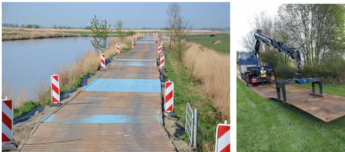
Abbildung 11: Provisorische Zuwegung und deren Errichtung
