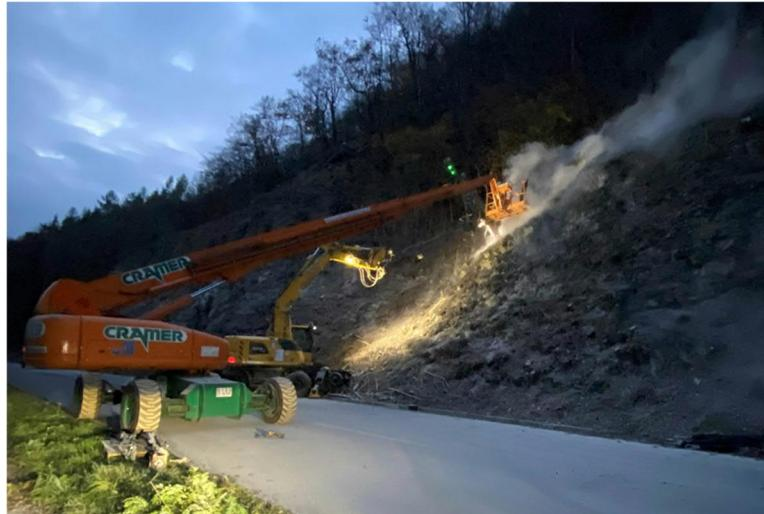
Die Bohrarbeiten am Hangfuß können auch bei Dunkelheit fortgesetzt werden. Die meisten Arbeiten im Hang müssen unter Nutzung des Tageslichtes erfolgen. Hintergrund ist insbesondere die Arbeitssicherheit.
