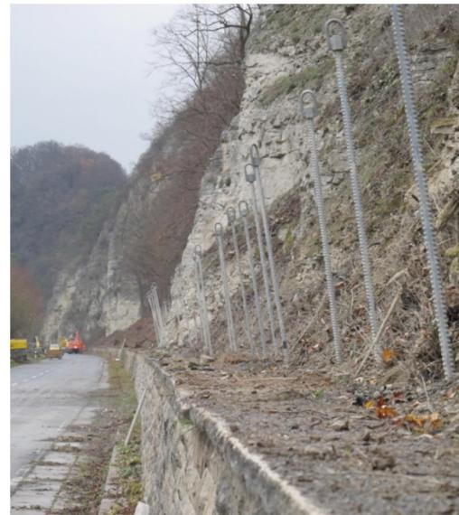
Nach dem Bohren werden die Anker mit Zement verpresst.
