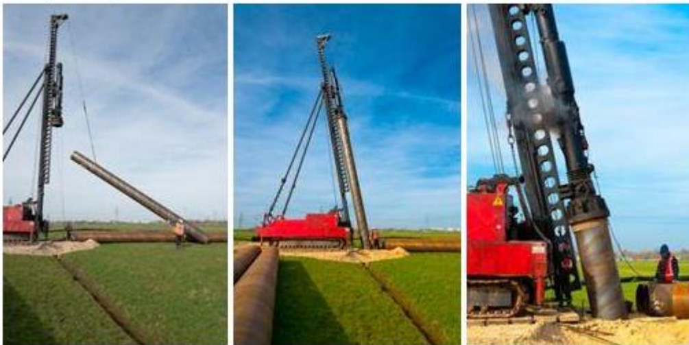
Abbildung 39: Pfahlgründung (Quelle: TenneT TSO GmbH)
