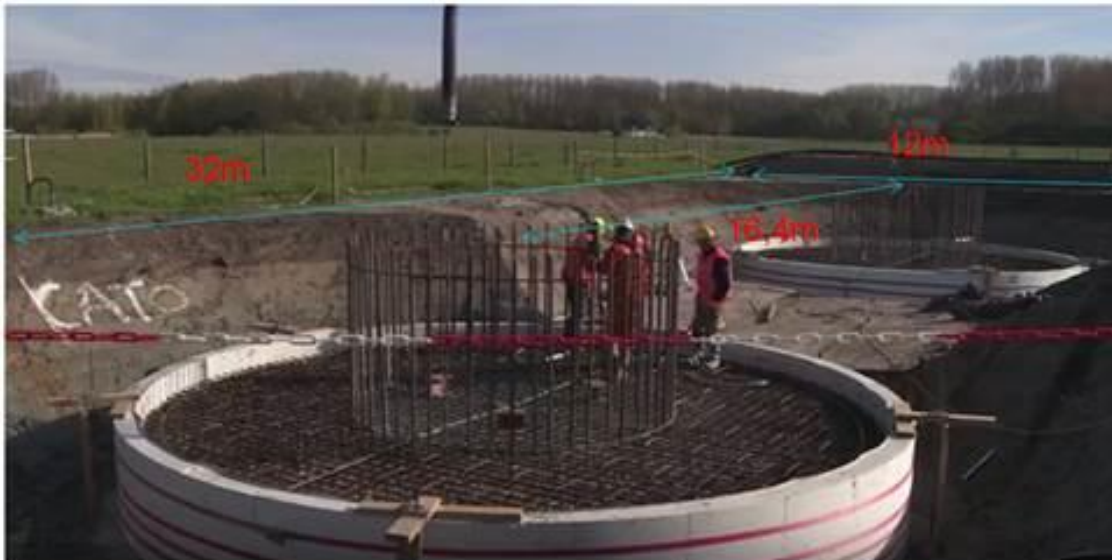
Abbildung 31: Baustellenfläche Kompaktmast – Ausführung Duo-Pol
