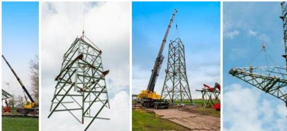
Abbildung 40: Stocken eines Freileitungsmastes (Quelle: TenneT TSO GmbH)
