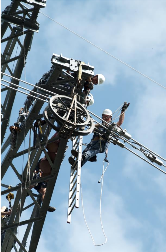
Abbildung 41: Seilzug (Quelle: TenneT TSO GmbH)
