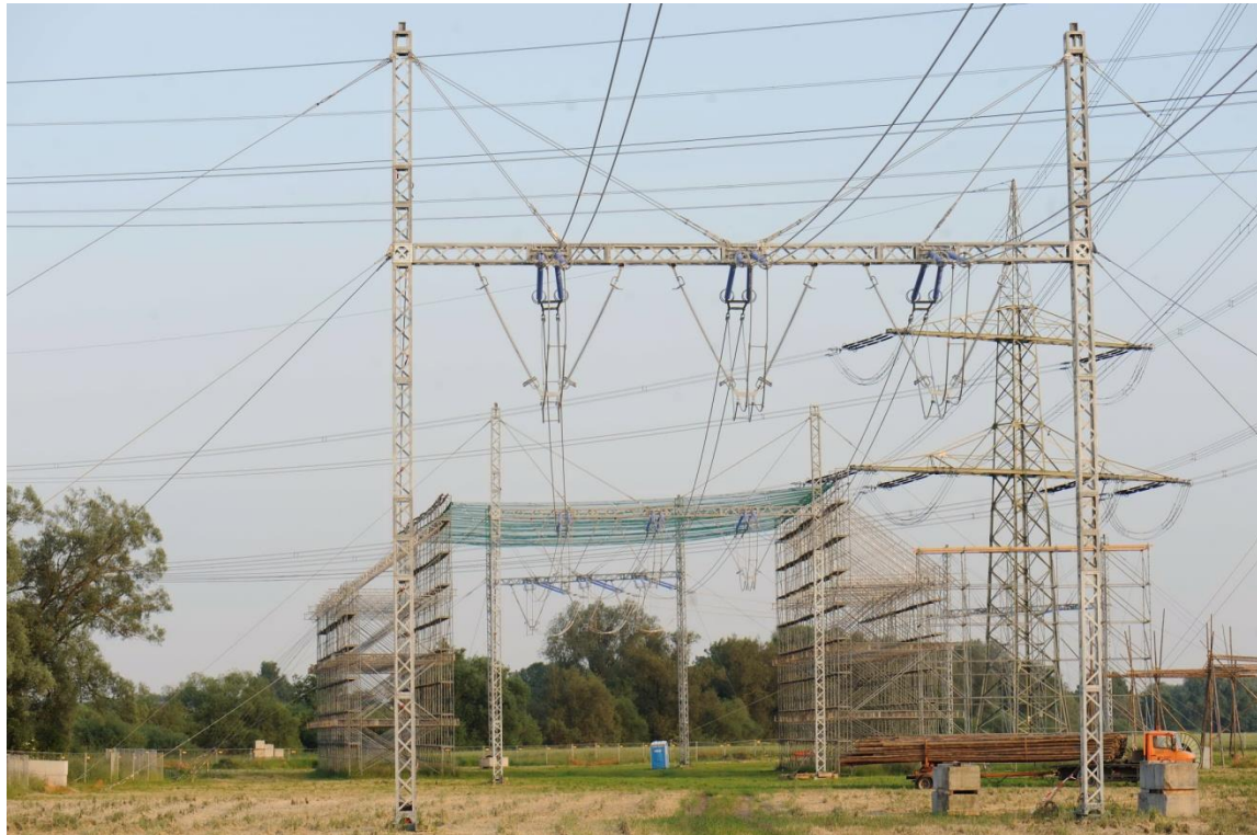
Abbildung 42: 380-kV-Freileitungsprovisorium für ein System, mit errichtetem Schutzgerüst
