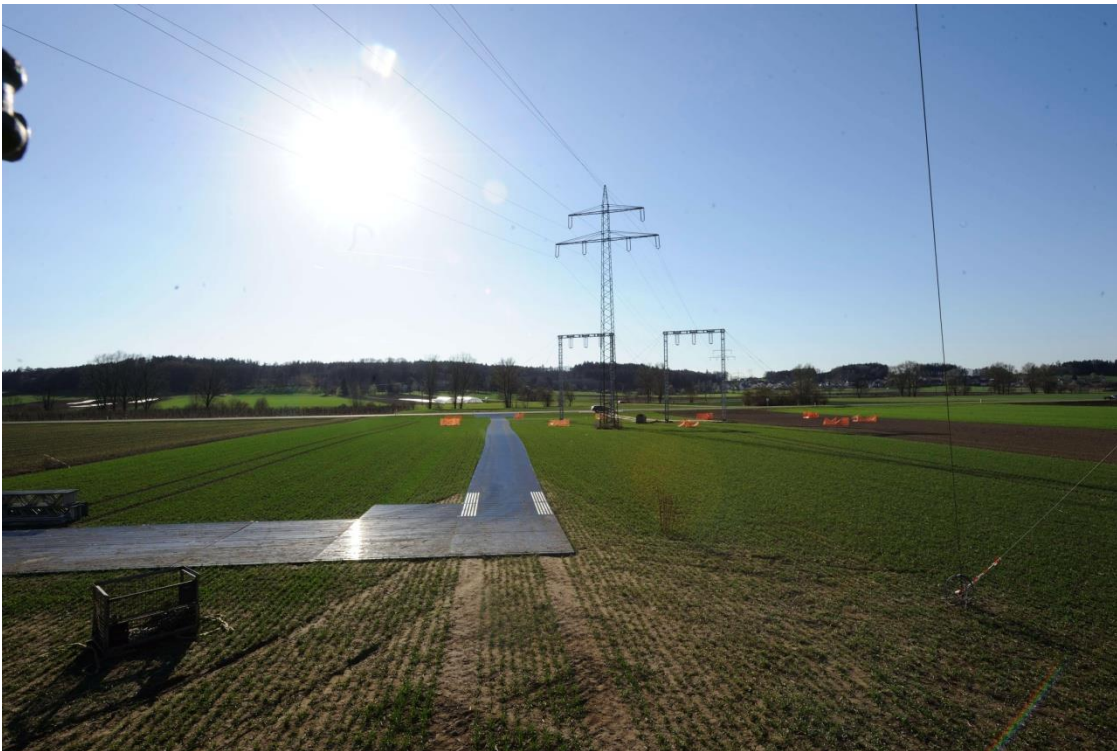
Abbildung 38: Provisorische Zuwegung als Plattendzufahrt bei einer Freileitungsbaustelle
