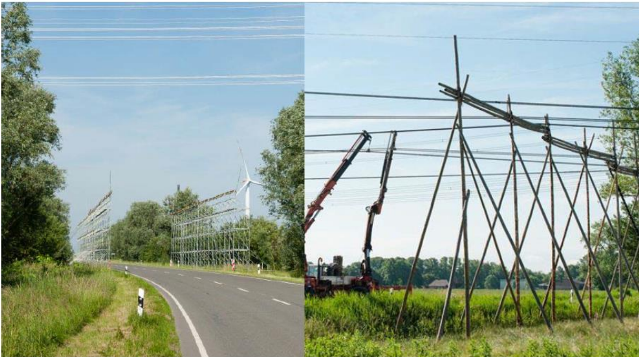
Abbildung 43: Beispiele für Schutzgerüste aus Stahl bzw. Holz
