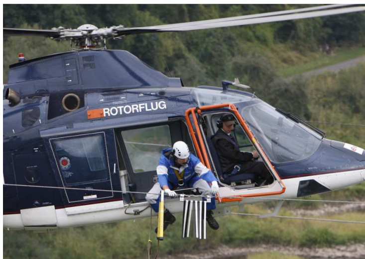
Abbildung 12: Exemplarische Darstellung der Erdseilmarkierung (Quelle: TenneT TSO GmbH)
