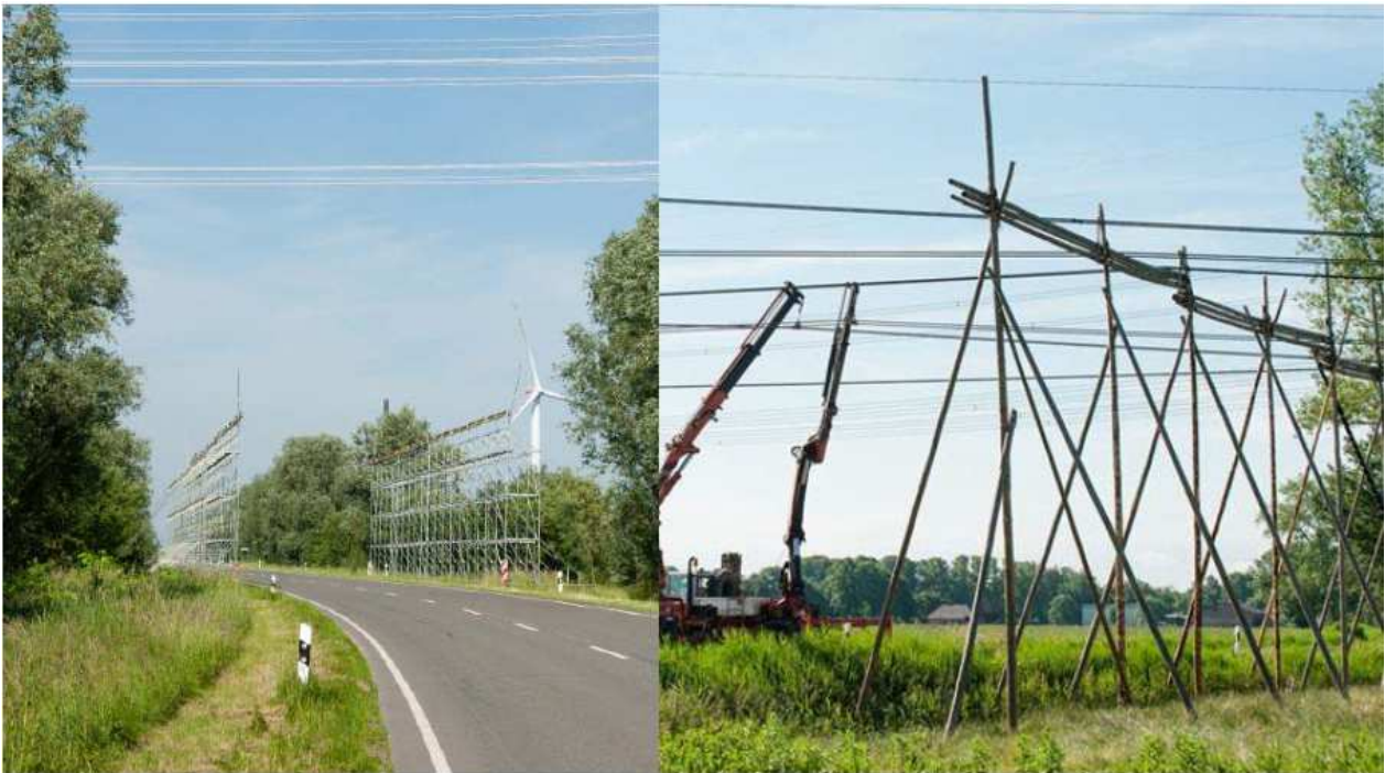
Abbildung 31: Beispiele für Schutzgerüste aus Stahl bzw. Holz
