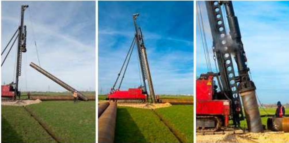
Abbildung 16: Pfahlgründung (Quelle: TenneT TSO GmbH)
