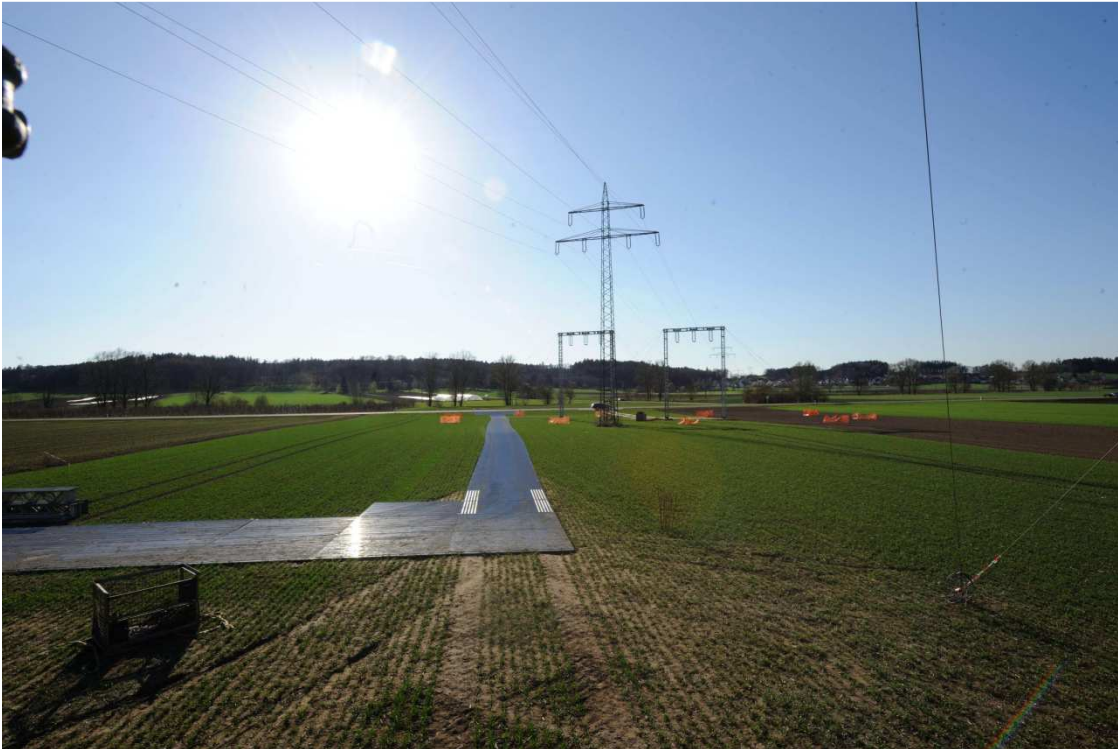
Abbildung 15: Provisorische Zuwegung als Plattenzufahrt bei einer Freileitungsbaustelle
