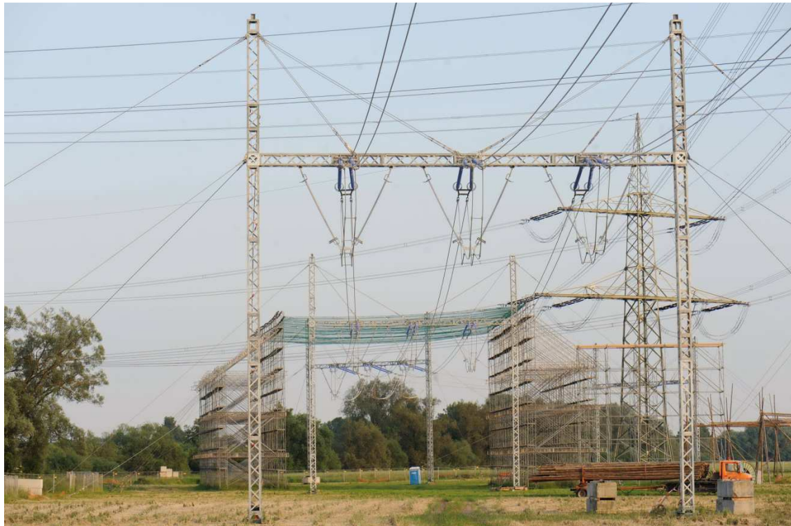
Abbildung 30: 380-kV-Freileitungsprovisorium für ein System, mit errichtetem Schutzgerüst
