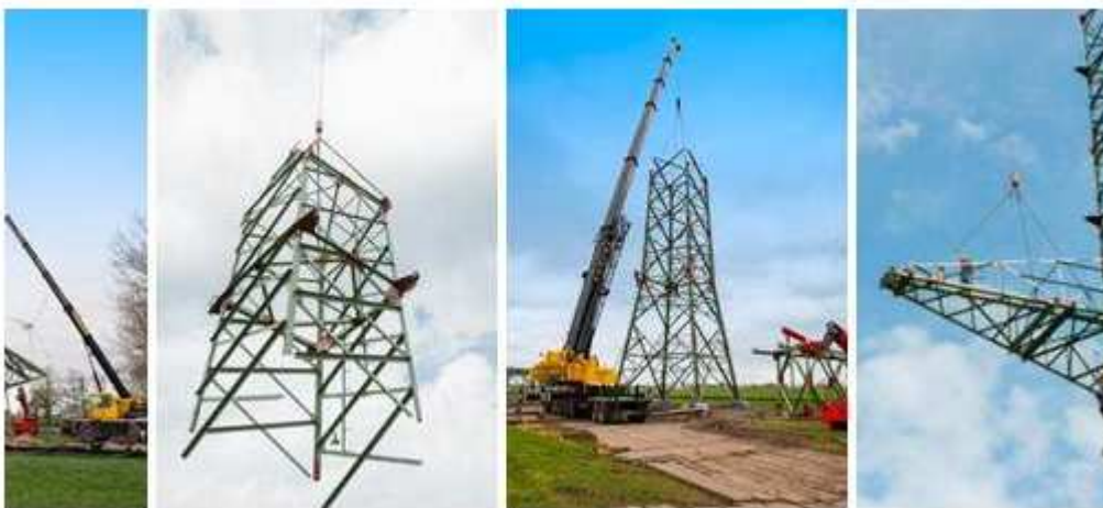
Abbildung 17: Stocken eines Freileitungsmastes (Quelle: TenneT TSO GmbH)
