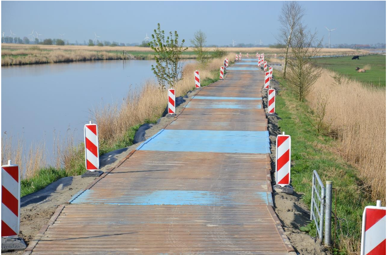
Abbildung 11: Provisorische Zuwegung als Plattenzufahrt bei einer Freileitungsbaustelle
