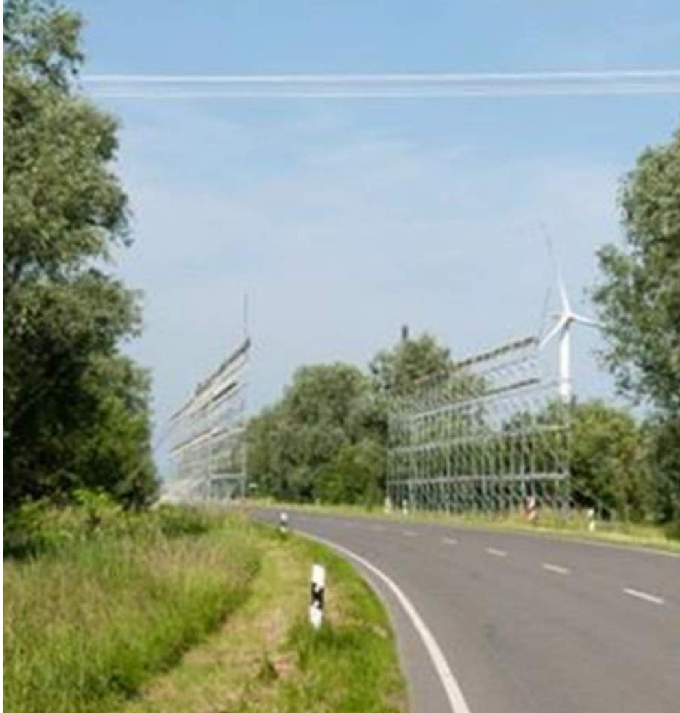
Abbildung 16: Beispiele für Schutzgerüste aus Stahl
