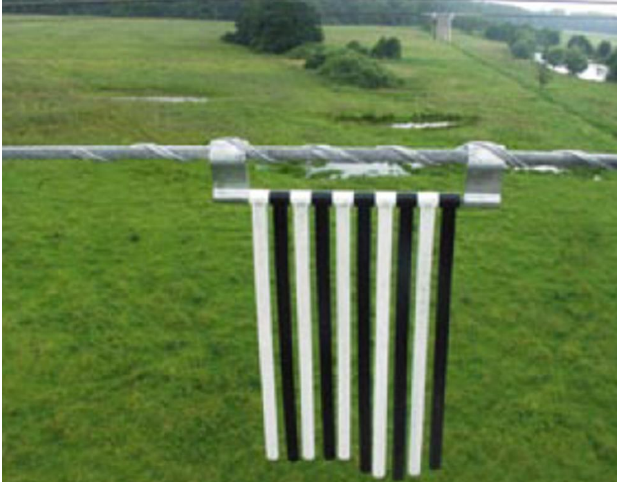
Abbildung 3: Beispiel einer schwarz-weißen Erdseilmarkierung (Quelle: RIBE)
