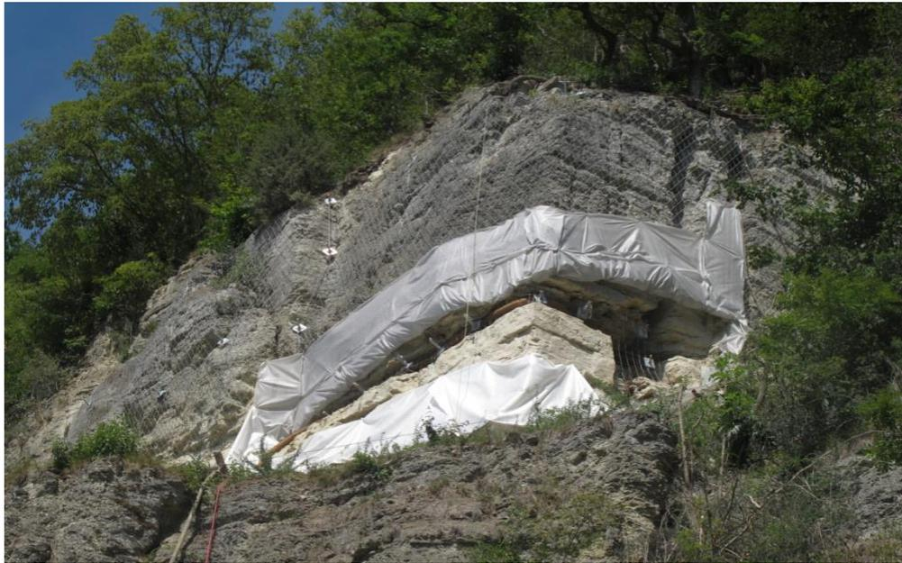
Damit Wasser aus den Klüften weiterhin austreten kann, wurden Drainagen eingebaut.
