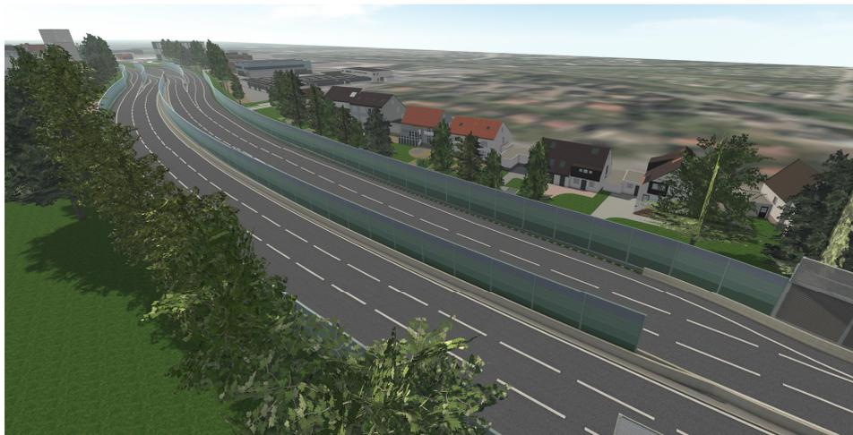
Lärmschutzwände an den Fahrbahnrändern und im Mittelstreifen zum Schutz der Wohnbebauung zwischen Tunnelportal Ost und dem Trog unter den DB-Brücken
