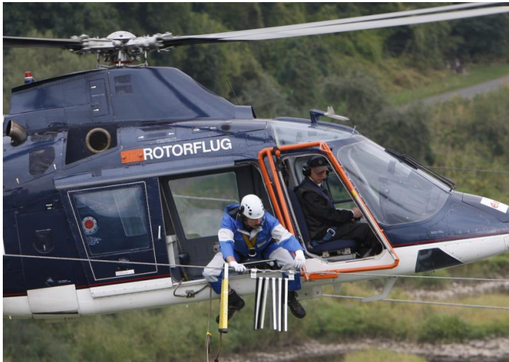
Abbildung 15: Exemplarische Darstellung der Erdseilmarkierung (Quelle: TenneT TSO GmbH)
