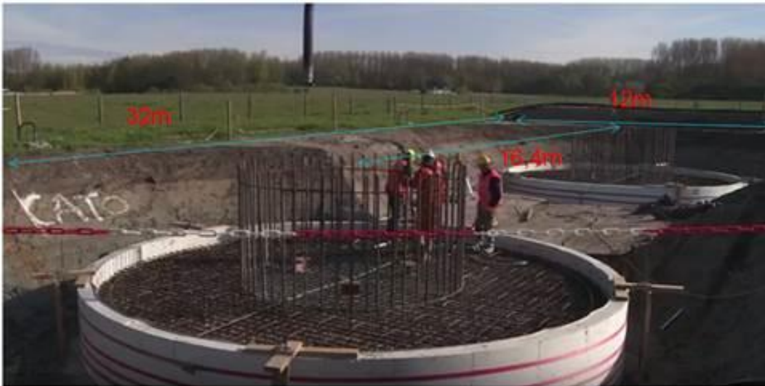
Abbildung 11: Baustellenfläche Kompaktmast – Ausführung Duo-Pol
