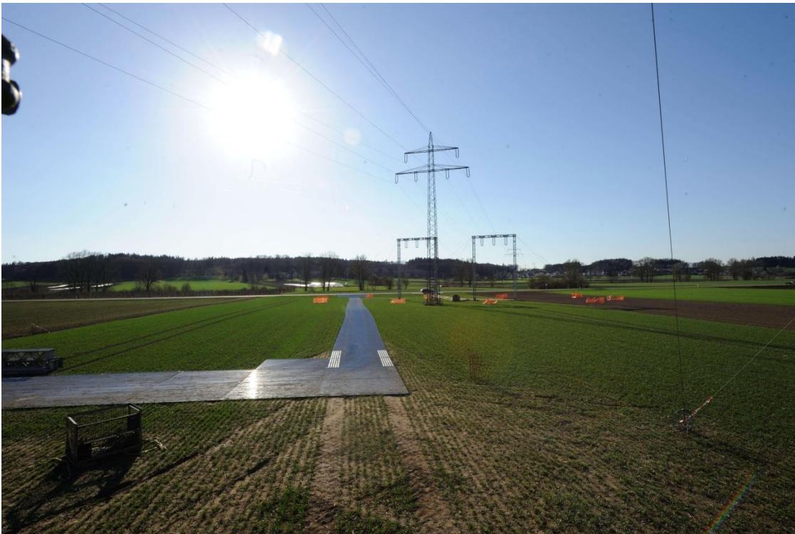
Abbildung 18: Provisorische Zuwegung als Plattenzufahrt bei einer Freileitungsbaustelle
