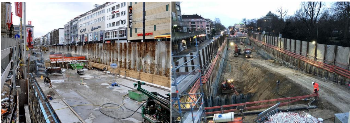
Abbildung 1 Tunnel Kriegsstraße, Kombi-Lösung Karlsruhe im Zuge der B 10 (links Rohbau, rechts Bodenaushub)
