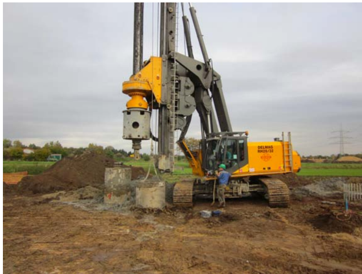
Abbildung 4: Bohrung für einen Bohrpfahl
