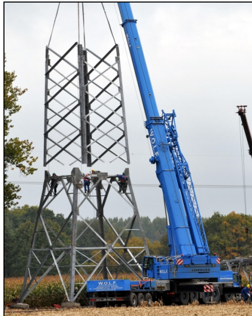
Abbildung 8: Mastmontage (Stocken)
