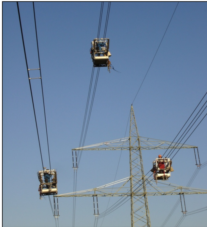
Abbildung 12: Montage der Feldbündelabstandhalter mit Fahrwagen
