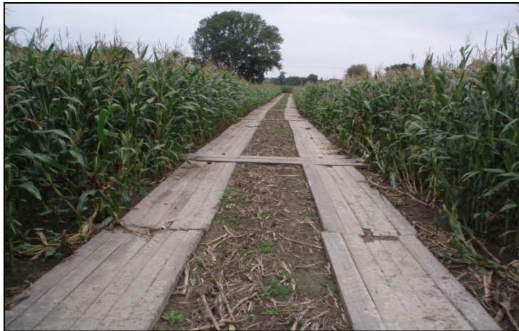
Abbildung 1: Temporäre Zuwegung über Fahrbohlen
