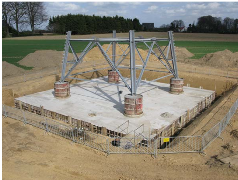
Abbildung 3. Erstellung eines Plattenfundamentes
