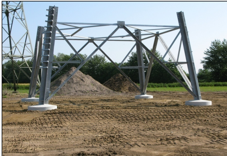
Abbildung 7: Montierter Mastfuß
