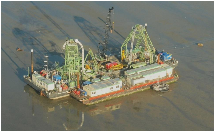
Abbildung 6: Verlegebarge/Arbeitsponton mit Unterküften
