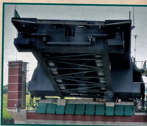
Die beiden Hydraulikzylinder haben jeweils etwa **370 TONNEN HUBKRAFT.**
