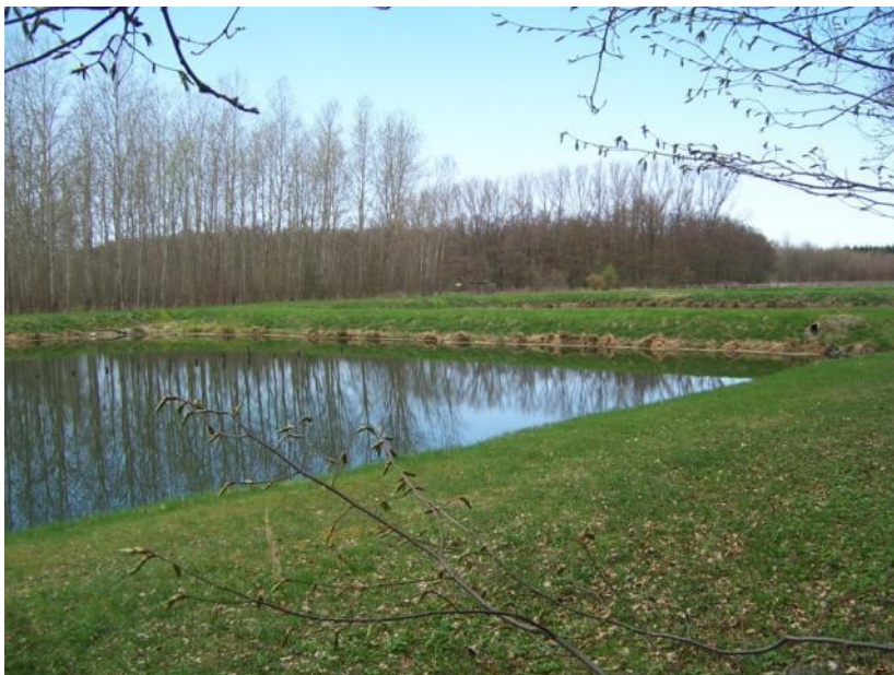
Abbildung 33: Klärteiche der Abwasserentsorgungsanlage Ehra, südl. Ehra
