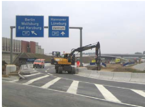
Bauarbeiten im Autobahndreieck Braunschweig-Südwest
