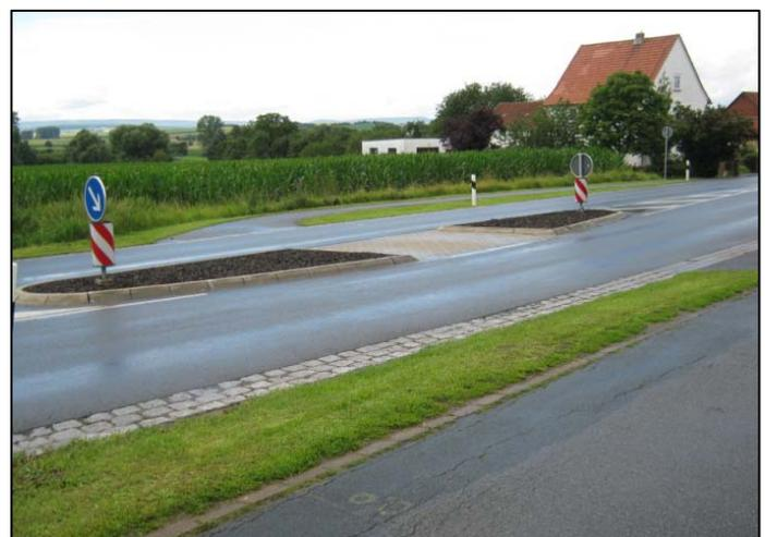
Bereits vorh. Mittelinsel zur sicheren Überleitung des Radverkehrs auf den noch zu bauenden Geh- und Radweg
