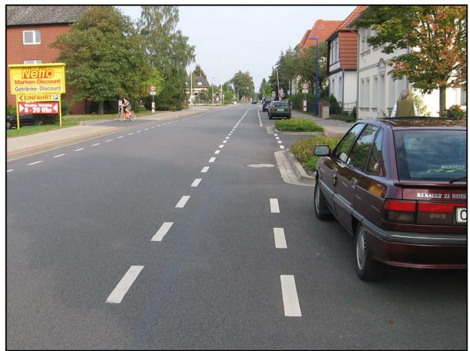
Bild 12: Schutzstreifen mit Sicherheitsraum zu Parkständen
