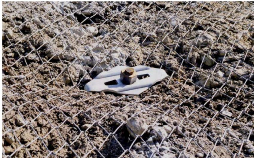
Abbildung 17: Böschungsvernagelung - Drahtgeflecht mit Krallenplatte
