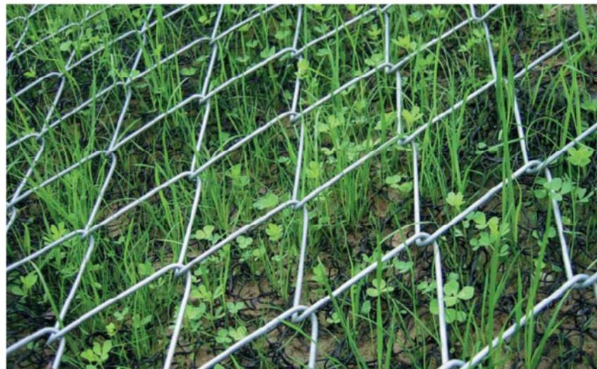
Abbildung 18: Böschungsvernagelung - Drahtgeflecht mit Pflanzenaufwuchs
