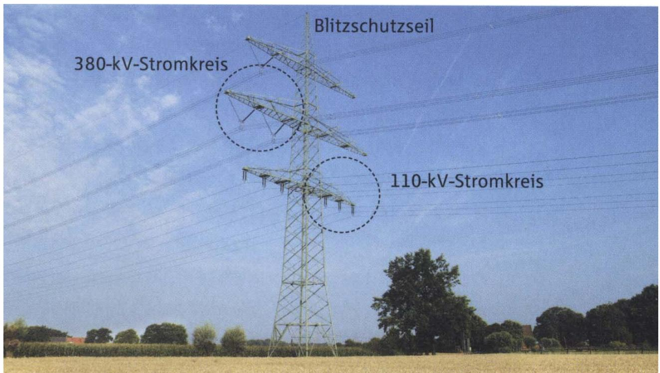
Foto: Darstellung eines 380-kV-Stromkreises und eines 110-kV-Stromkreises auf einem Mast
