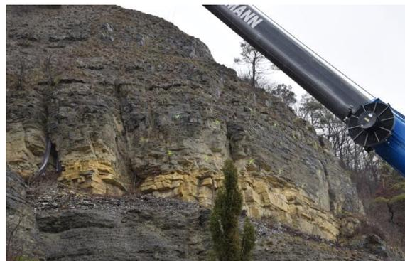
Maximale mögliche Neigung des Kranauslegers mit der daran angehängten Last der Bohrlaffete. Höhere Lasten bringen den Kran zum Kippen.
