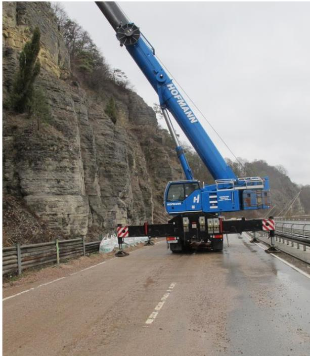
Der Raum zum Ausfahren der Stützen, das sogenannte Abpratzen, des Kranes ist in der Breite beschränkt. Wegen der weseitigen Stützwand wurde berechnet, welche Kräfte über die Stützen in den Untergrund geleitet werden können. Die Ausgleichsgewichte am Kran sind ausgereizt.
